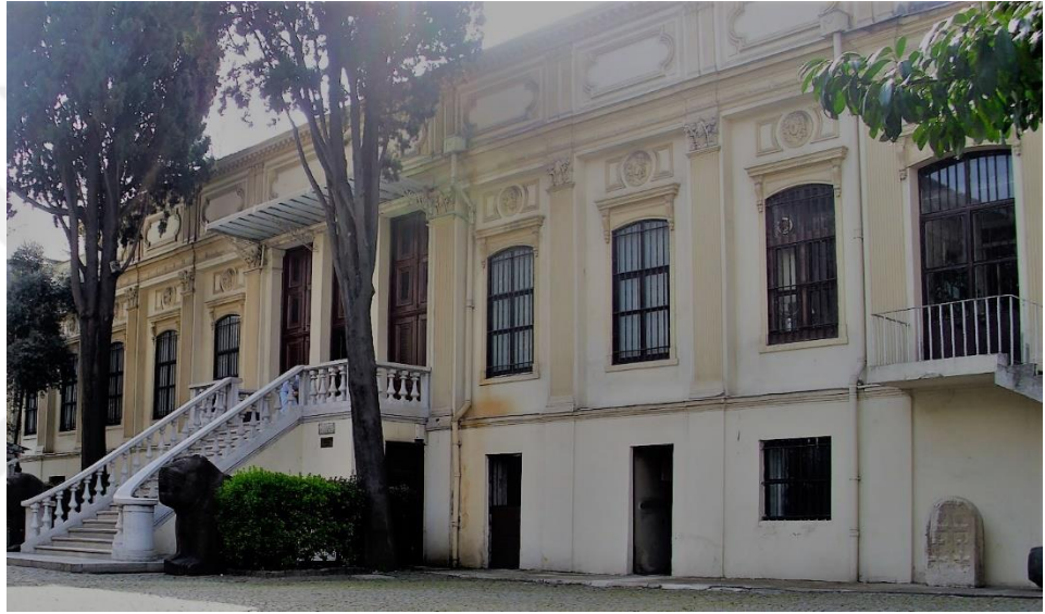
Şekil 4-76 Eski Şark Eserleri Müzesi Ön Cephesi (Tuğ'un Arşivinden)
