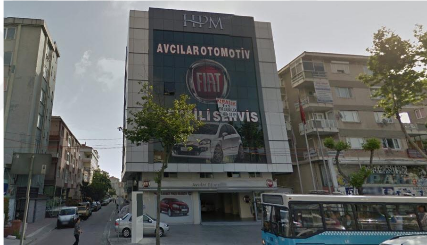
Şekil 4-92 Haluk Perk Müzesi Ön Cephesi (Tuğ'un Arşivinden)
