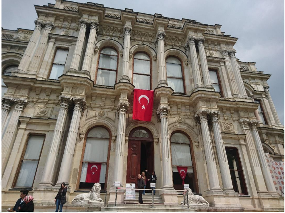
Şekil 4-48 Beylerbeyi Sarayı Ön Cephesi (Tuğ'un Arşivinden)
