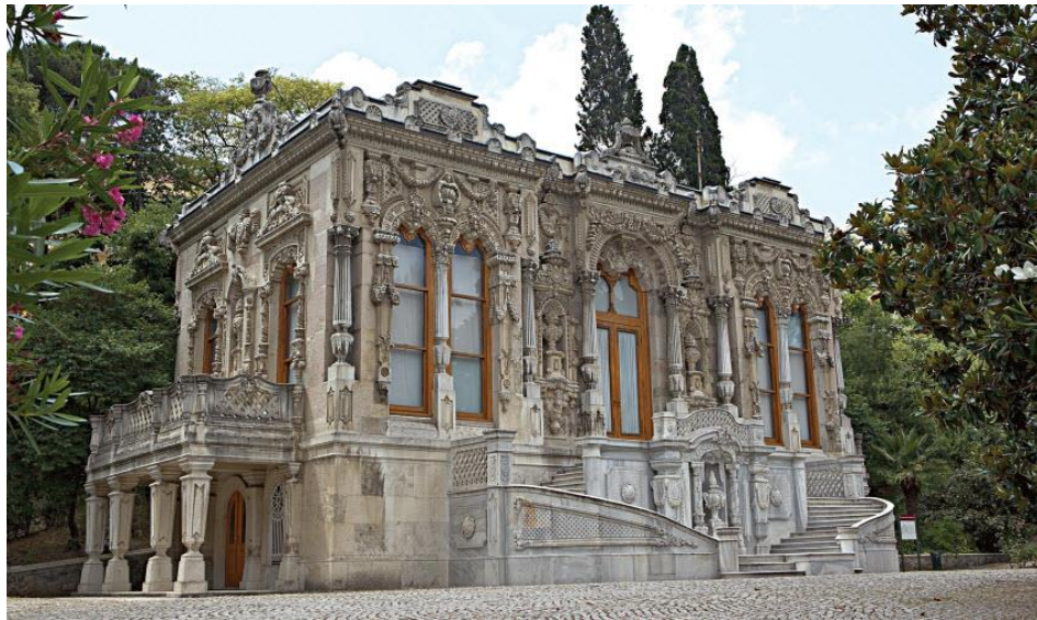
Şekil 4-104 Marsim Köşkü Ön Cephesi (Tuğ'un Arşivinden)
