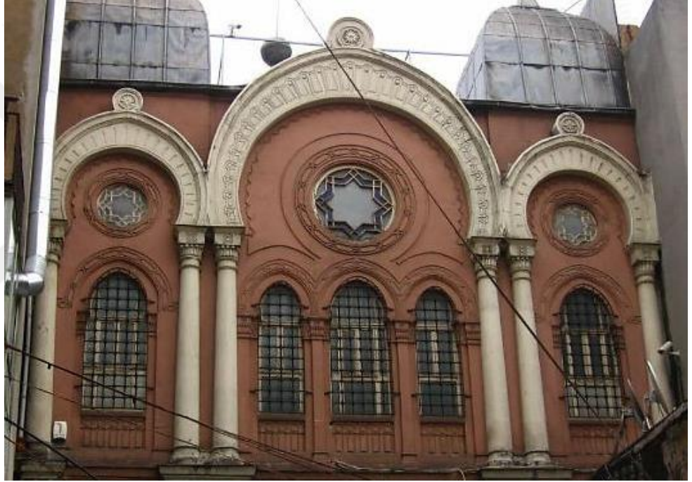
Şekil 4-1 Neve Şalom Sinagogu (Tuğ'un Arşivinden)
