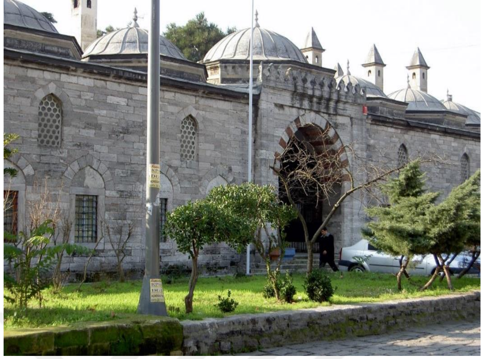
Şekil 4-211 Beyazıt Medresesi Dışarıdan Görünüm (Tuğ'un Arşivinden)
