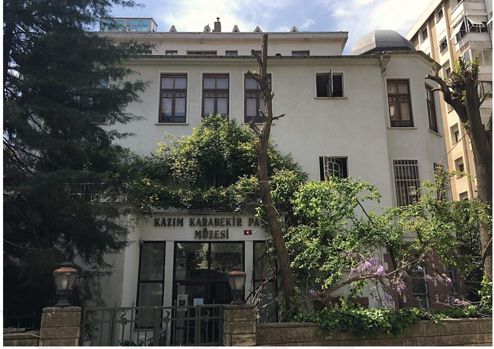
Şekil 4-142 Kazım Karabekir Paşa Müzesi Ön Cehesi (Tuğ'un Arşivinden)
