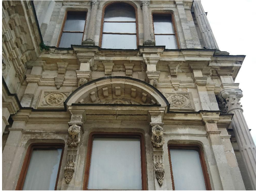
Şekil 4-50 Beylerbeyi Sarayı Cephe Süsleme Detayları (Tuğ'un Arşivinden)
