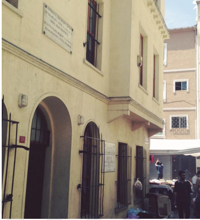
Şekil 4-5 Adam Mickiewicz Müzesi Ön Cephesi (Tuğ'un Arşivinden)
