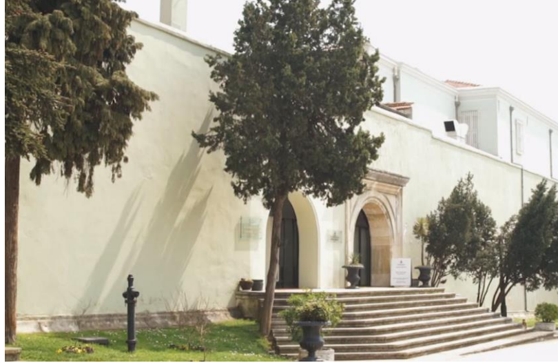
Şekil 4-197 Şehir Müzesi Ön Cephesi (Tuğ'un Arşivinden)
