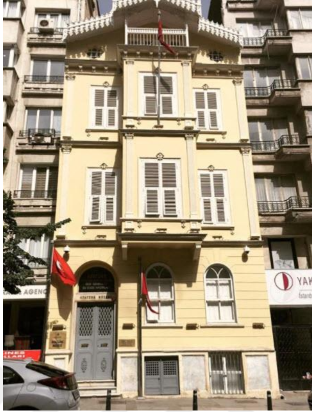
Şekil 4-16 Atatürk Müzesi Ön Cephesi (Tuğ'un Arşivinden)
