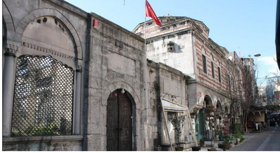
Şekil 4-210 Türk İnşaat ve Sanat Eserleri Müzesi Ön Cephesi (Tuğ'un Arşivinden)
