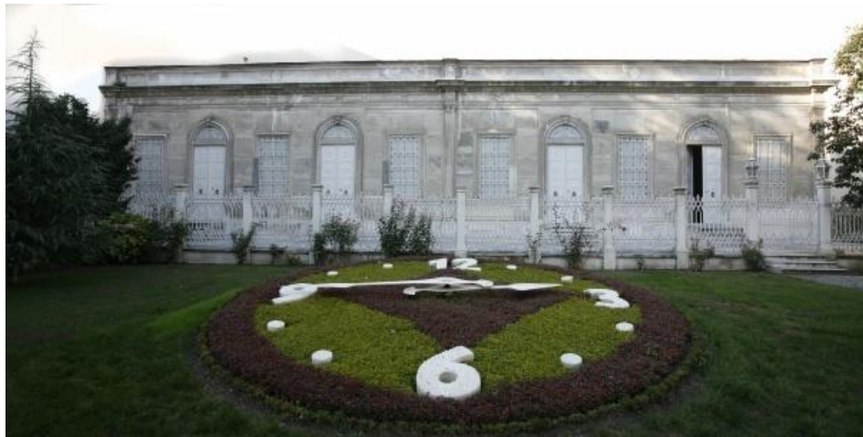
Şekil 4-72 Dolmabahçe Saat Müzesi Ön Cephesi (Tuğ'un Arşivinden)
