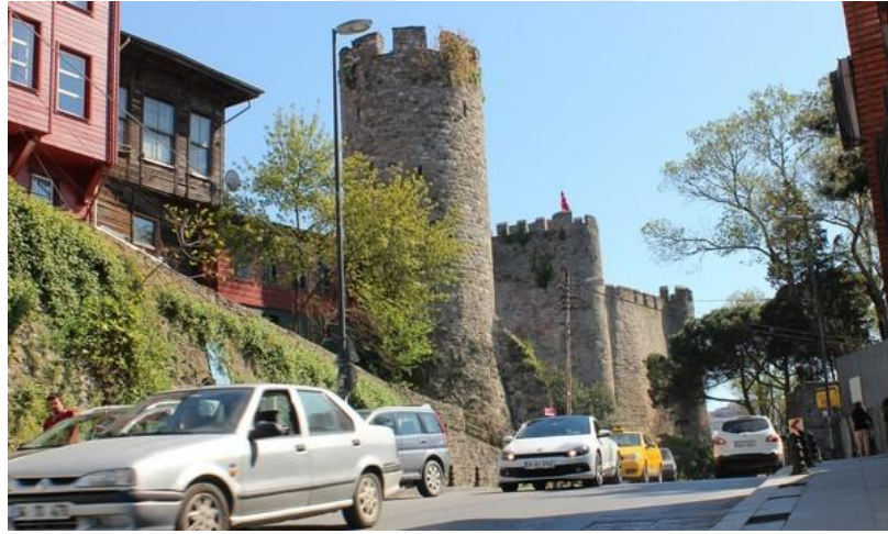
Şekil 4-10 Anadolu Hisarı Dışarıdan Görünüm (Tuğ'un Arşivinden)
