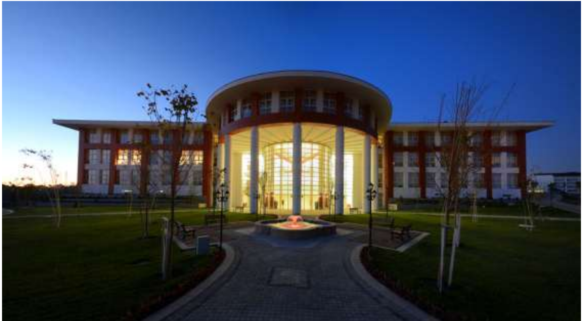
Şekil 4.26. Atılım Üniversitesi İdari Binası (Url-30).
