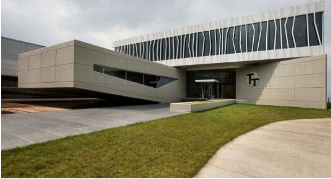
Şekil 4.23. TAEGUTEC Fabrika ve Yönetim Binası (Url-28).
