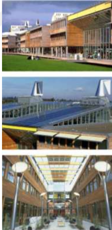
Şekil 2.3. Nottingham Üniversitesi Jubilee kampüsü Binalarında Fotovoltaik Pıl Kullanımı (Url-2).
