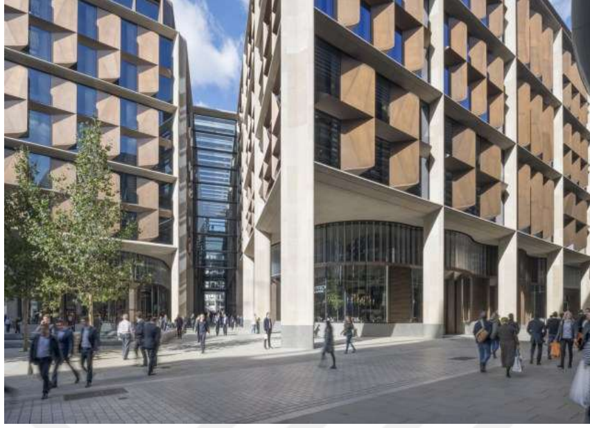
Şekil 4.17. Bloomberg Merkez Binası (Url-24).
