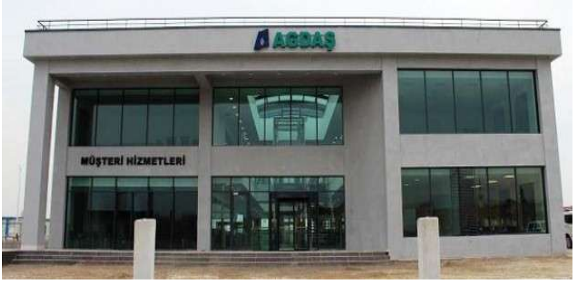
Şekil 4.30. Agdaş Genel Müdürlük Binası (Url-34).
