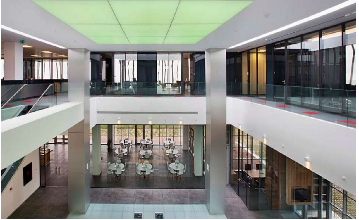
Şekil 4.24. TAEGUTEC Fabrika ve Yönetim Binası (Url-28).
