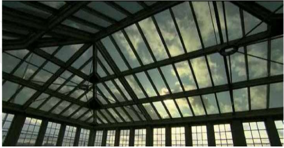
Şekil 3.20. Norden Denizcilik Merkez Binası Cam Çatı' dan Yansıyan gün ışığı (Url-8).
