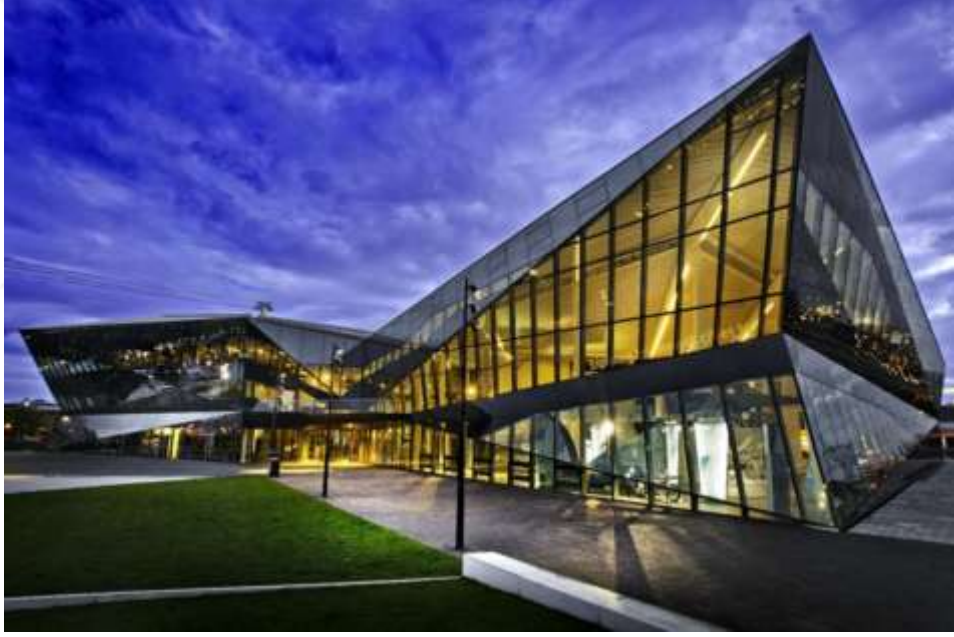
Şekil 4.6. Siemens The Crystal Binası(Url-20).
