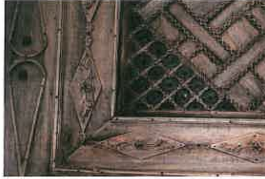
Şekil 3.35. Tavanda kullanılan metal çiviler ve pullar
