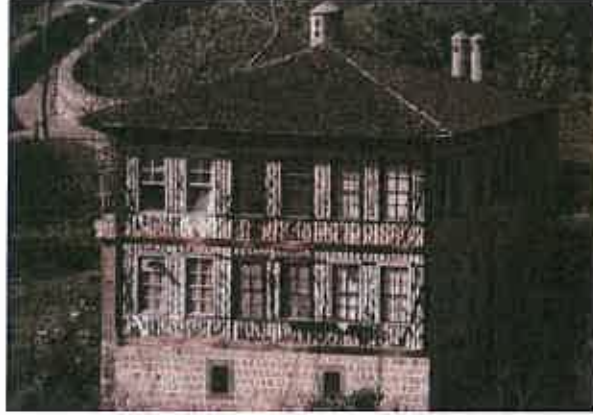
Şekil 3.7. Türk Evi’nde dolma göz duvar örneği
