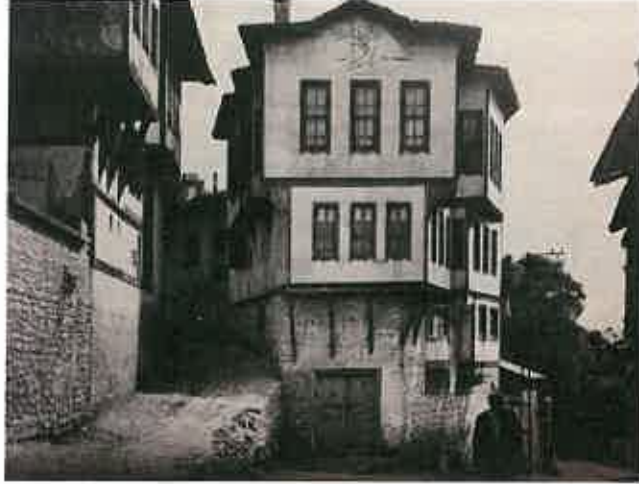
Şekil 4.1. Karaosmanlar Şehir Evi- Engebeli arazi de cephe görüntüsüne bir örnek (Günay, Safranbolu Evleri sf: 33)
