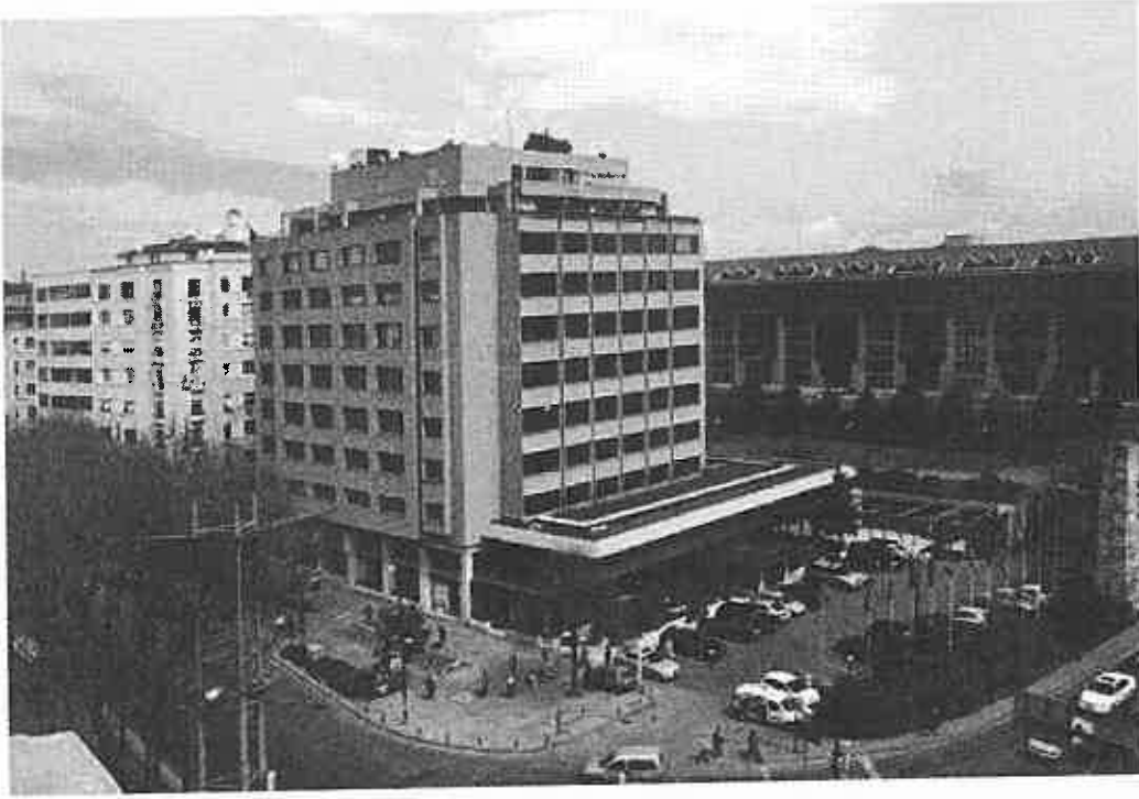
Şekil 4.1. : Eski Divan Otelinin Dış Görünüşü
