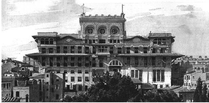
Şekil 4.4: Osmanlı bankası güney cephesi (5 Eylül 1896 tarihli L'illustration dergisi, Osmanlı Bankası Arşivi)
