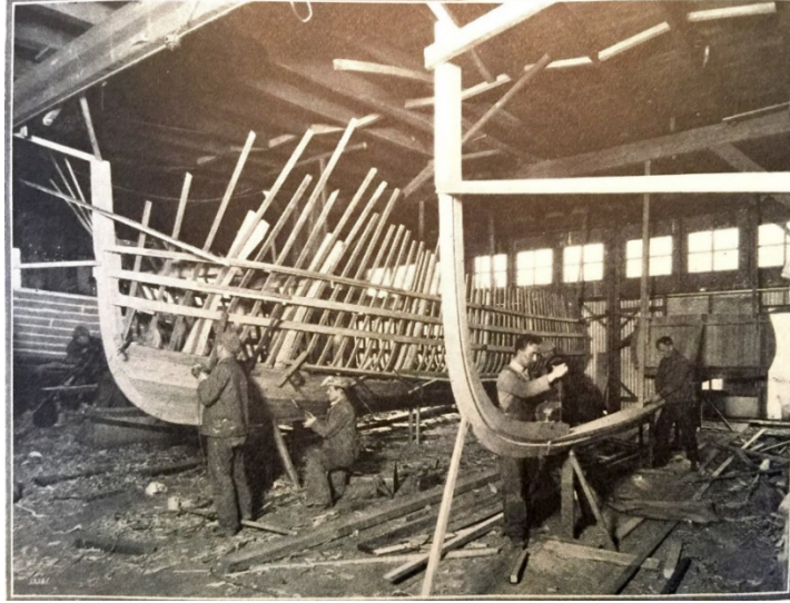
Şekil 4.4 Ahşap malzeme ile üretilmekte olan tekneler (The Rudder, February 1929: 108)
