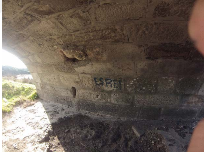
Şekil B.14: Büyükkarıştıran Köprüsü Kemer – 7 fotoğrafı
