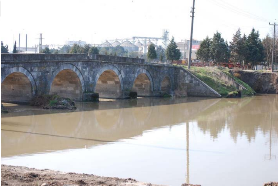
Şekil B.44: Büyükkarıştıran Köprüsü kuzey cephesi fotoğrafı
