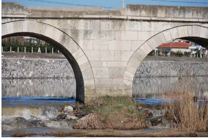
Şekil B.23: Büyükkarıştıran Köprüsü 4 No'lu ayak fotoğrafı
