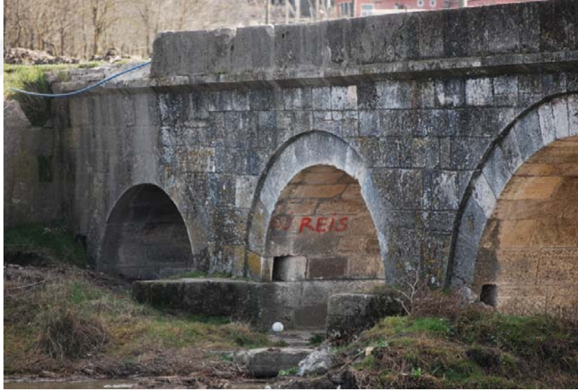
Şekil B.32: Büyükkarıştıran Köprüsü 8 No'lu ayak fotoğrafı
