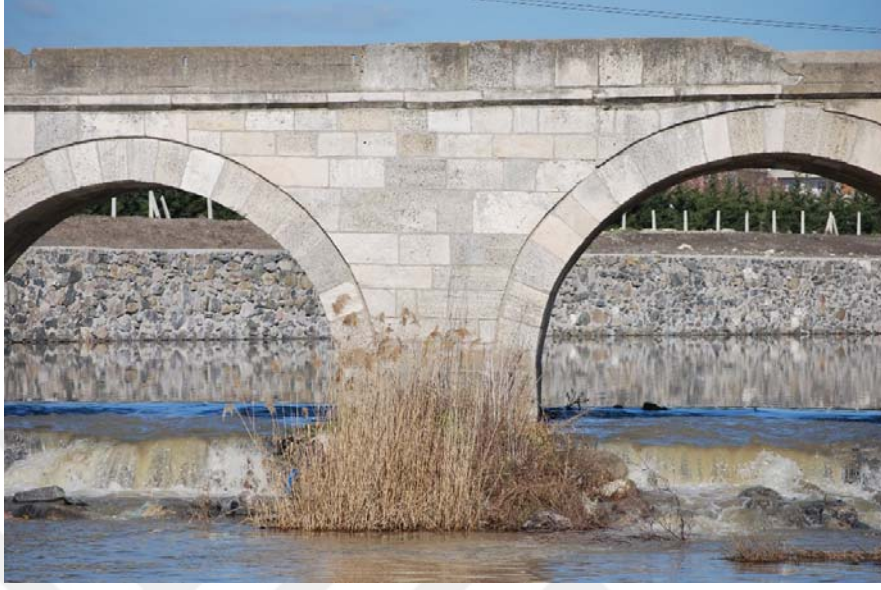
Şekil B.21: Büyükkarıştıran Köprüsü 3 No'lu ayak fotoğrafı
