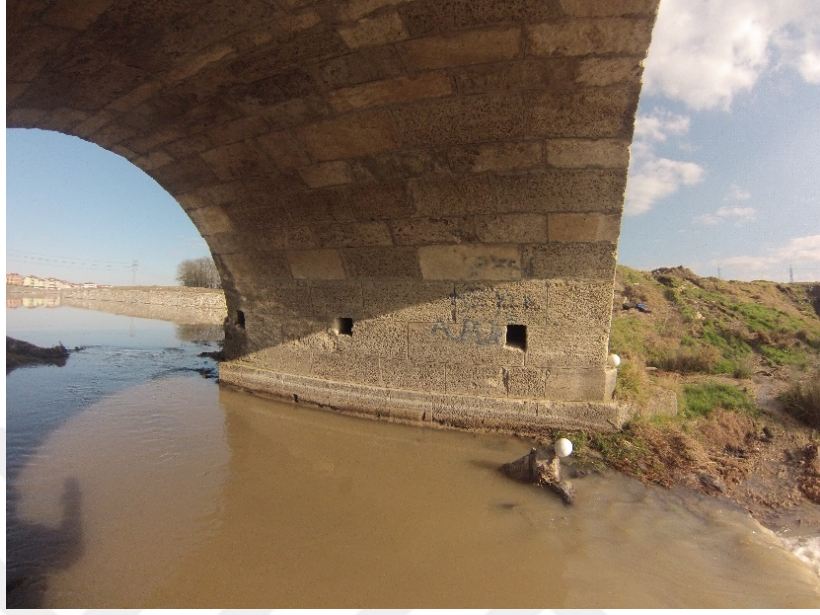
Şekil B.9: Büyükkarıştıran Köprüsü Kemer – 5 fotoğrafı
