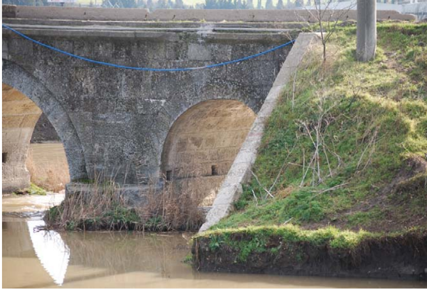
Şekil B.20: Büyükkarıştıran Köprüsü 2 No'lu ayak fotoğrafı
