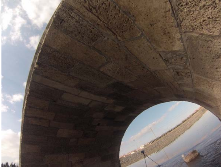
Şekil B. 8: Büyükkarıştıran Köprüsü Kemer – 4 fotoğrafı
