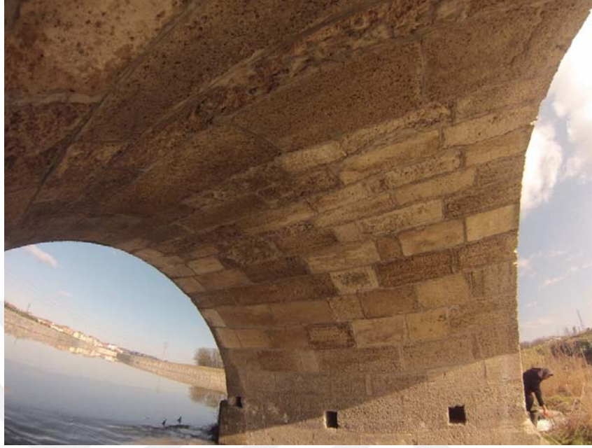
Şekil B.3: Büyükkarıştıran Köprüsü Kemer – 2 fotoğrafı
