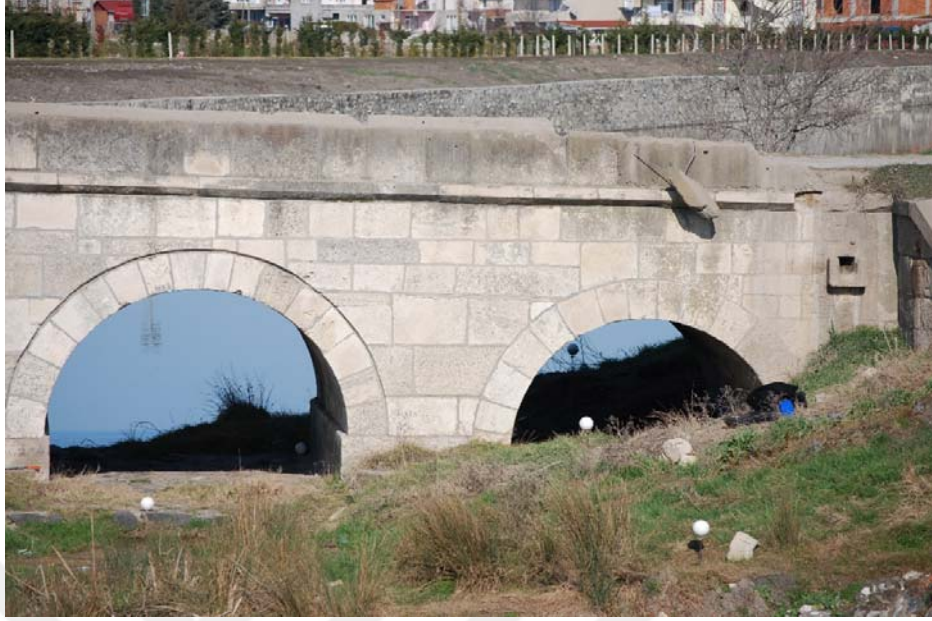
Şekil B.29: Büyükkarıştıran Köprüsü 7 No'lu ayak fotoğrafı
