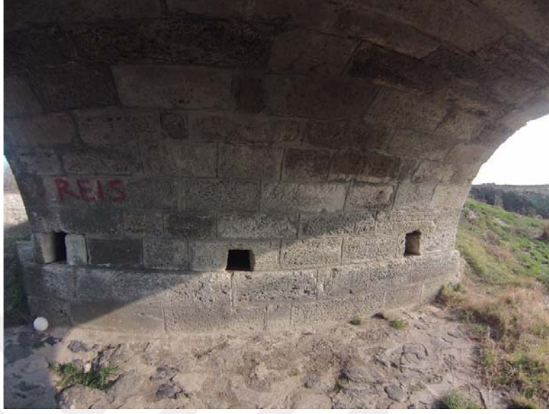
Şekil B.11: Büyükkarıştıran Köprüsü Kemer – 6 fotoğrafı
