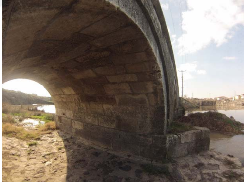
Şekil B.12: Büyükkarıştıran Köprüsü Kemer – 6 fotoğrafı
