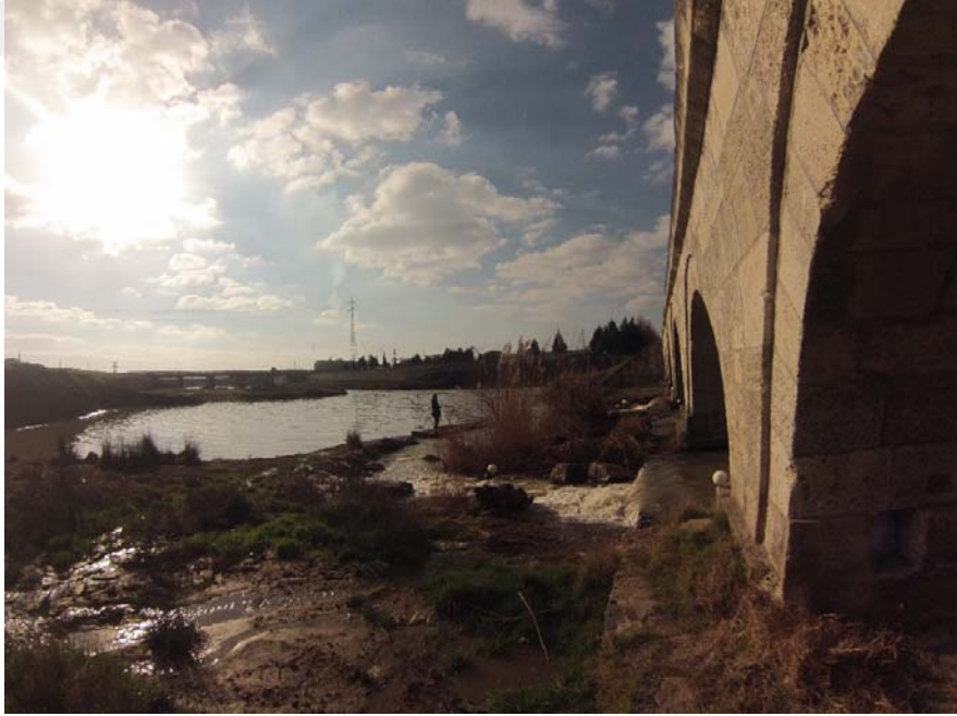
Şekil B.50: Büyükkarıştıran Köprüsü güney cephesi fotoğrafı
