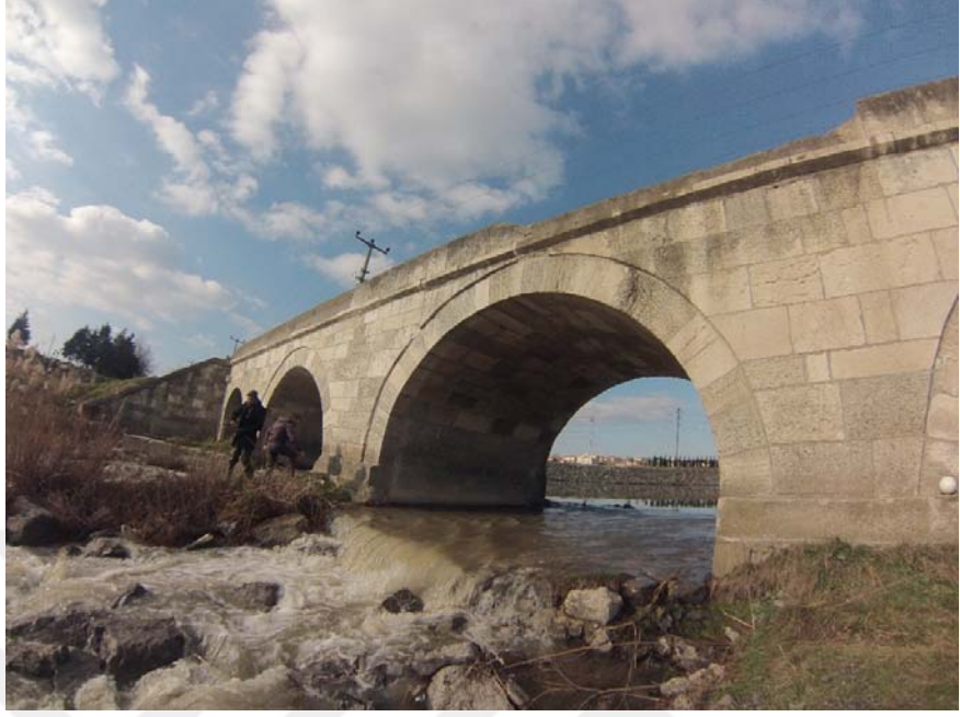
Şekil B.49: Büyükkarıştıran Köprüsü güney cephesi fotoğrafı
