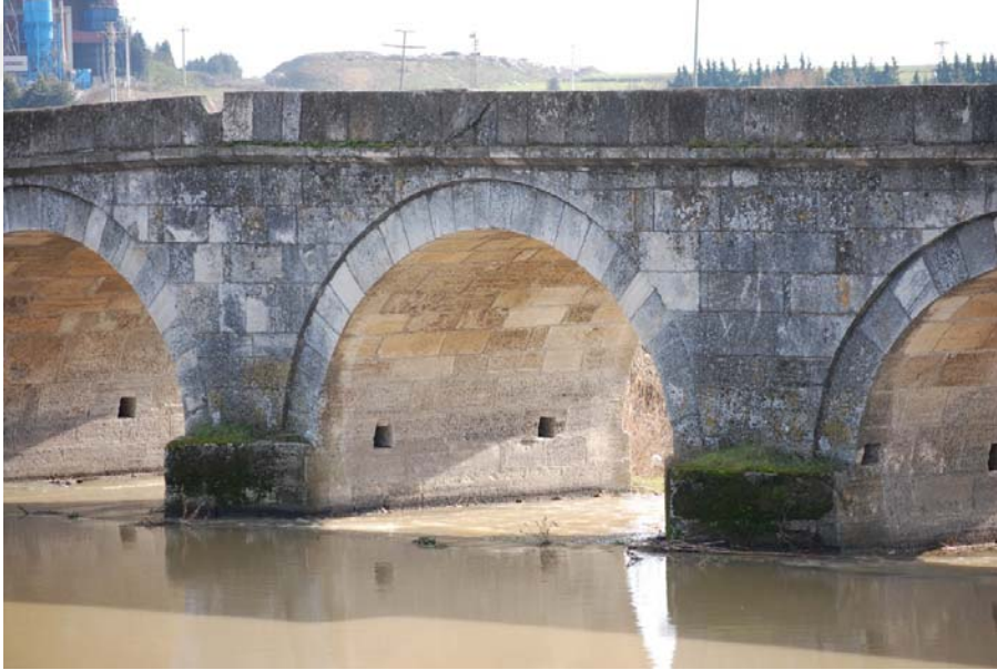
Şekil B.22: Büyükkarıştıran Köprüsü 3 No'lu ayak fotoğrafı
