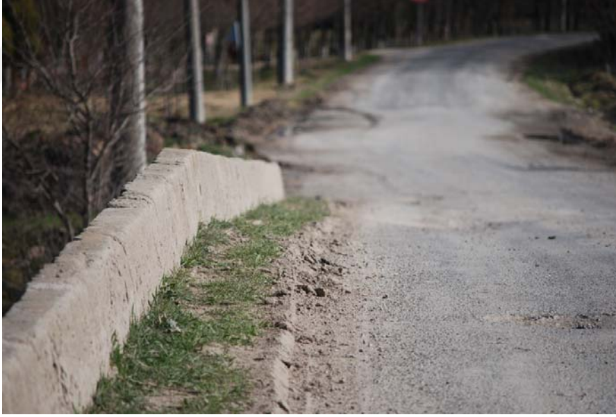
Şekil B. 36: Büyükkarıştıran Köprüsü parapet fotoğrafı
