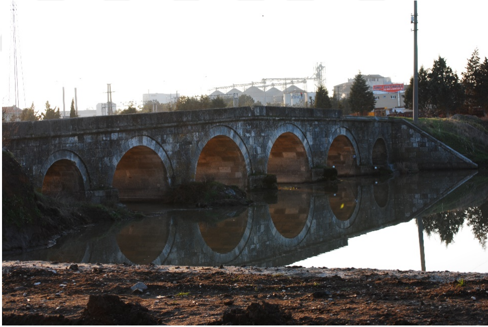
Şekil 3.1: Büyükkarıştıran köprüsü kuzey cephesi
