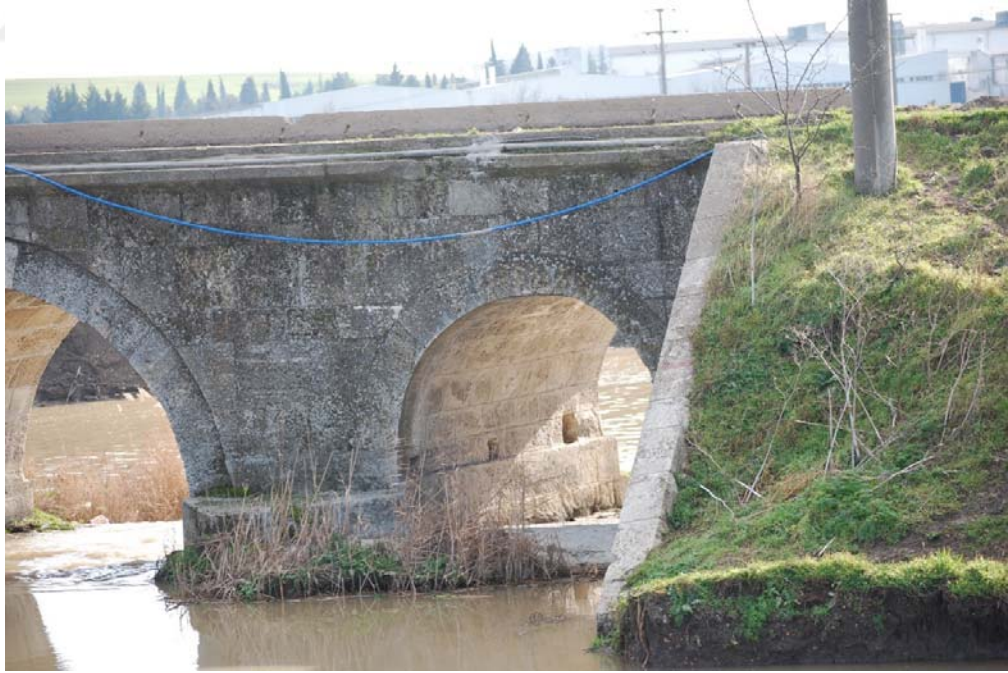
Şekil B.18: Büyükkarıştıran Köprüsü 1 No'lu ayak fotoğrafı
