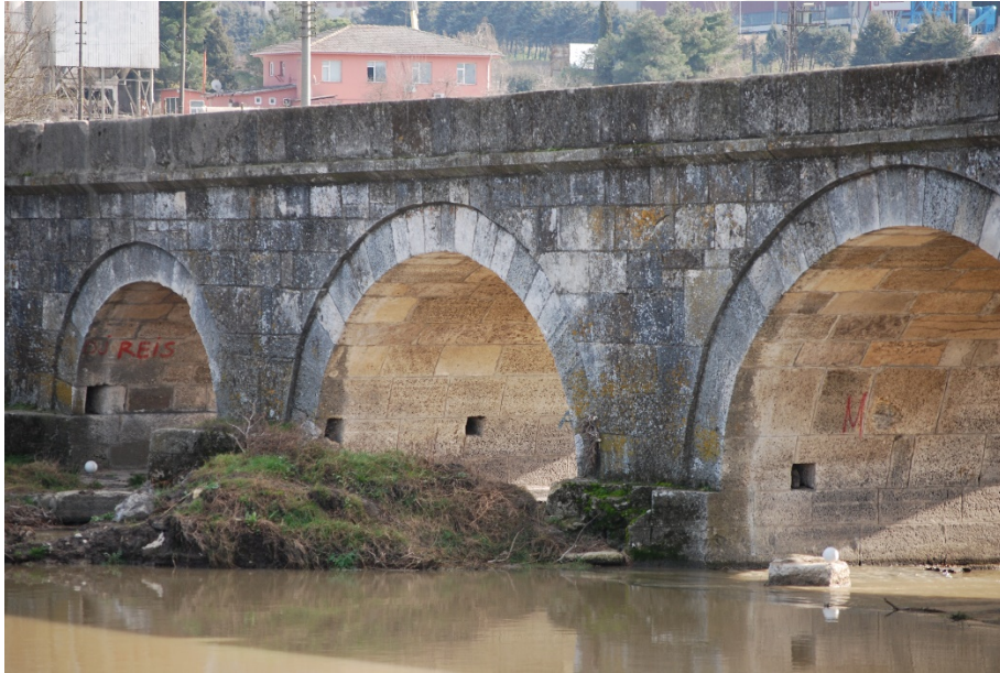
Şekil B.30: Büyükkarıştıran Köprüsü 7 No'lu ayak fotoğrafı
