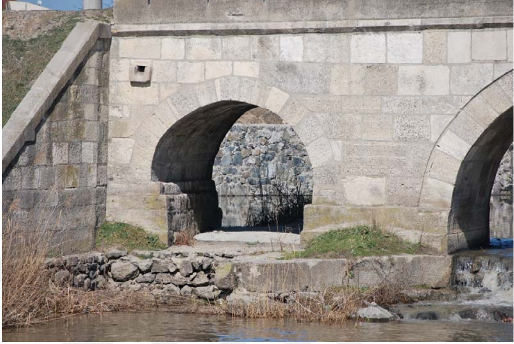
Şekil B.17: Büyükkarıştıran Köprüsü 1 No'lu ayak fotoğrafı
