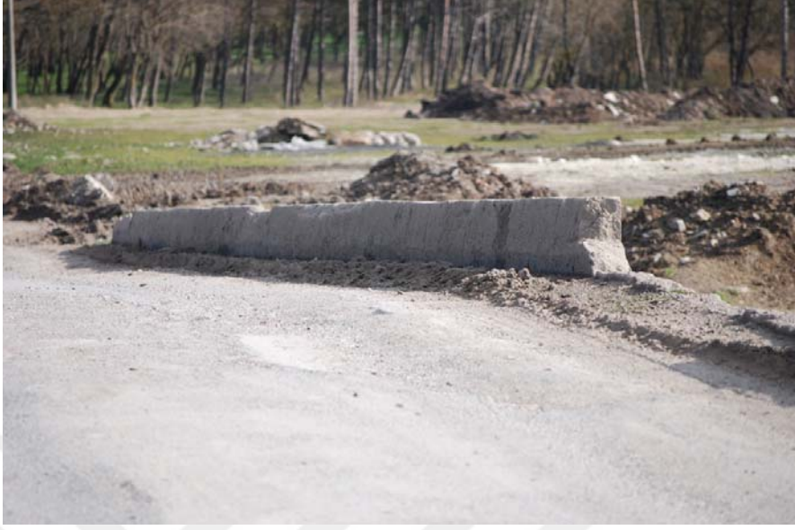
Şekil B.35: Büyükkarıştıran Köprüsü parapet fotoğrafı
