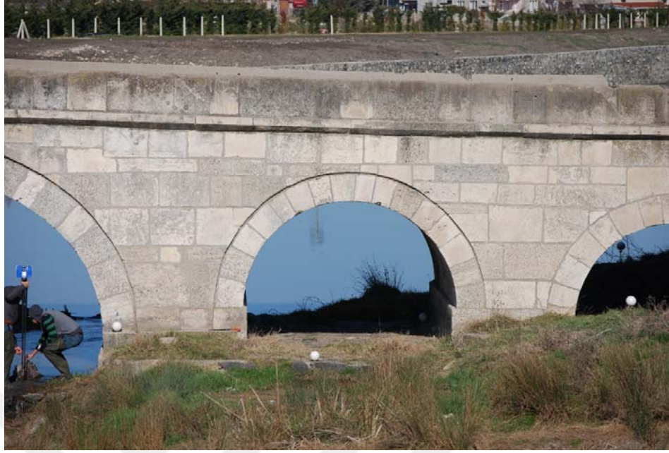
Şekil B.27: Büyükkarıştırıran Köprüsü 6 No'lu ayak fotoğrafı
