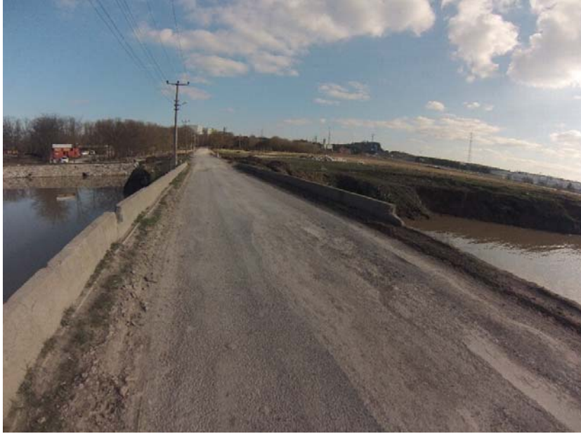
Şekil B.40: Büyükkarıştıran Köprüsü tabliye fotoğrafı
