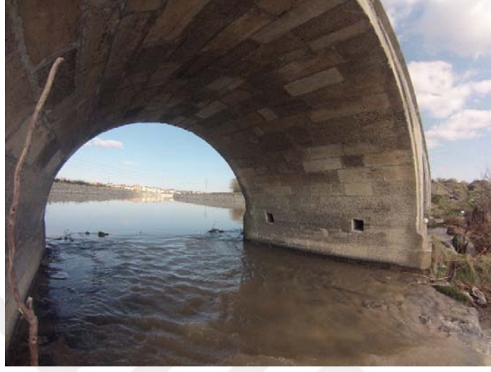
Şekil B.5: Büyükkarıştıran Köprüsü Kemer – 3 fotoğrafı
