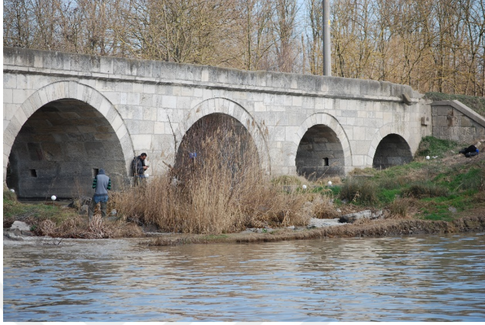
Şekil 3.6: Büyükkarıştıran köprüsü güney cephesi
