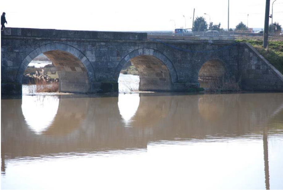
Şekil B.46: Büyükkarıştıran Köprüsü kuzey cephesi fotoğrafı
