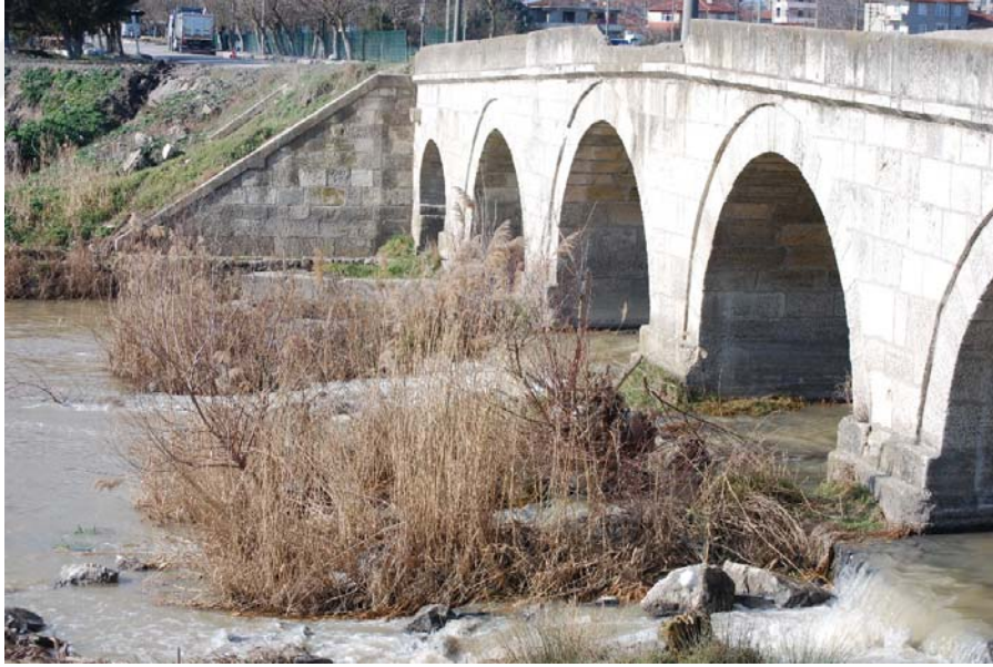
Şekil B.48: Büyükkarıştrın Köprüsü güney cephesi fotoğrafı
