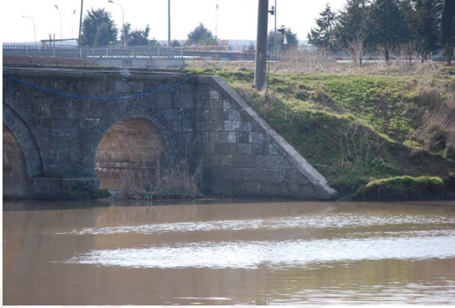
Şekil B.45: Büyükkarıştıran Köprüsü kuzey cephesi fotoğrafı
