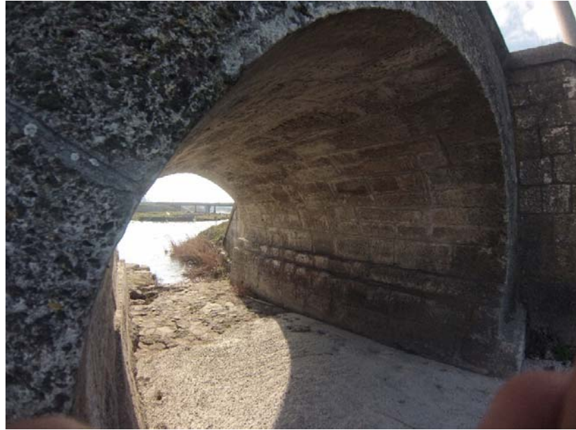
Şekil B.2: Büyükkarıştıran Köprüsü Kemer-1 fotoğrafı
