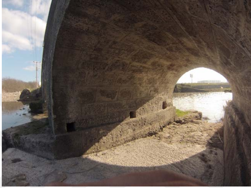
Şekil B.1: Büyükkarıştıran Köprüsü Kemer-1 fotoğrafı
