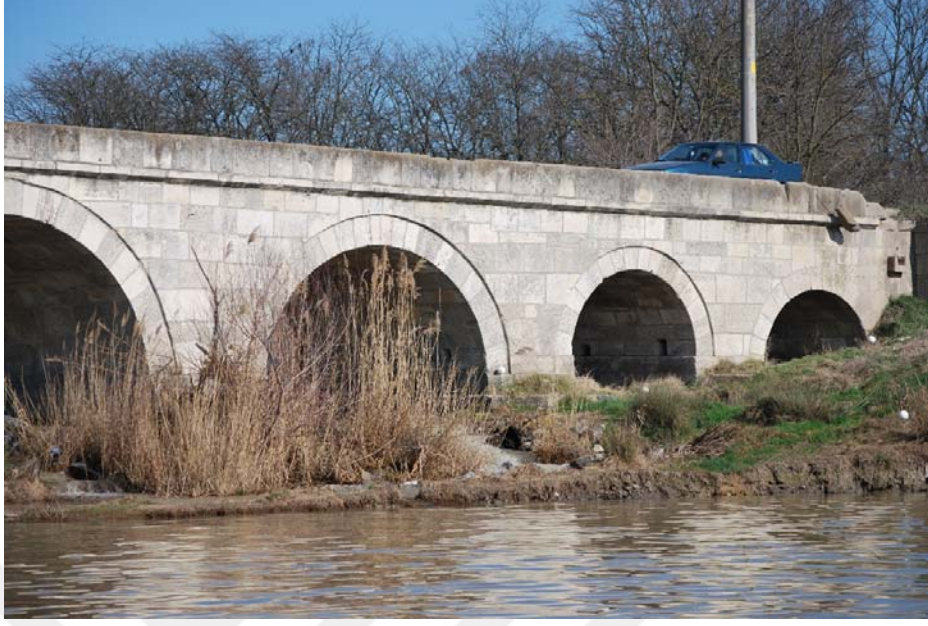
Şekil B.47: Büyükkarıştrın Köprüsü güney cephesi fotoğrafı
