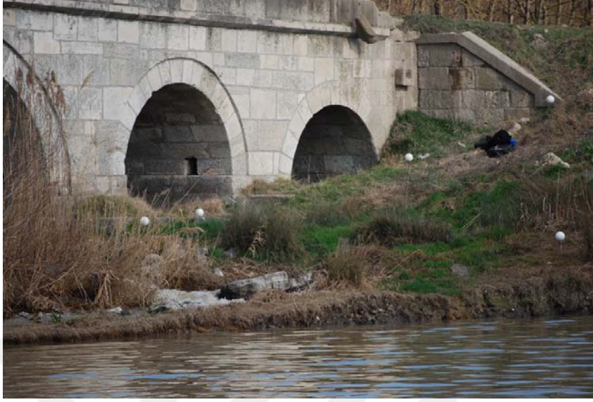
Şekil B.31: Büyükkarıştıran Köprüsü 8 No'lu ayak fotoğrafı
