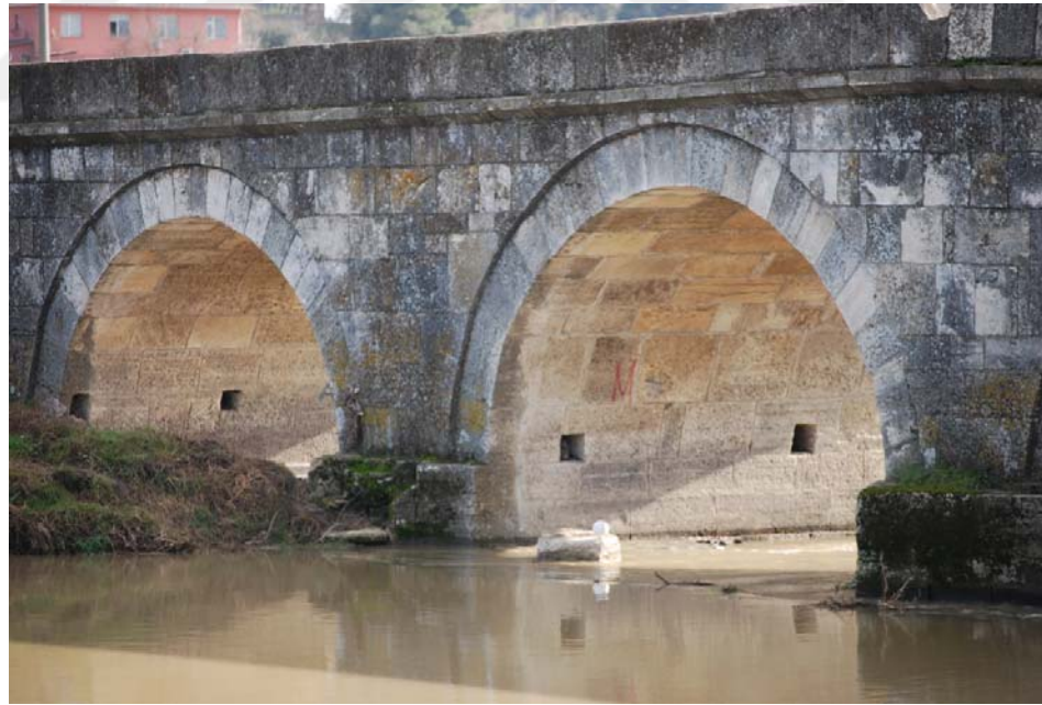
Şekil B.28: Büyükkarıştırıran Köprüsü 6 No'lu ayak fotoğrafı
