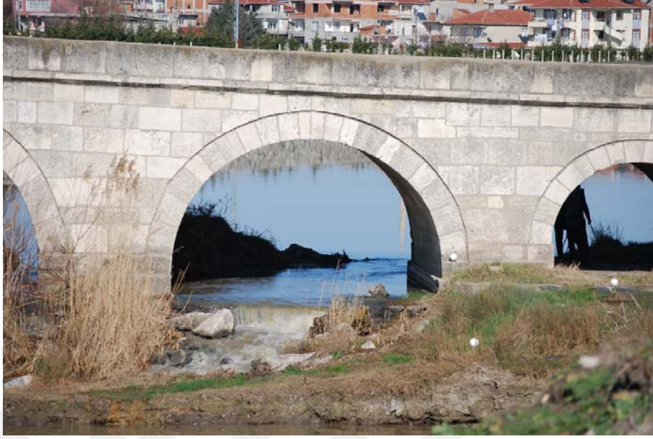
Şekil B.25: Büyükkarıştıran Köprüsü 5 No'lu ayak fotoğrafı
