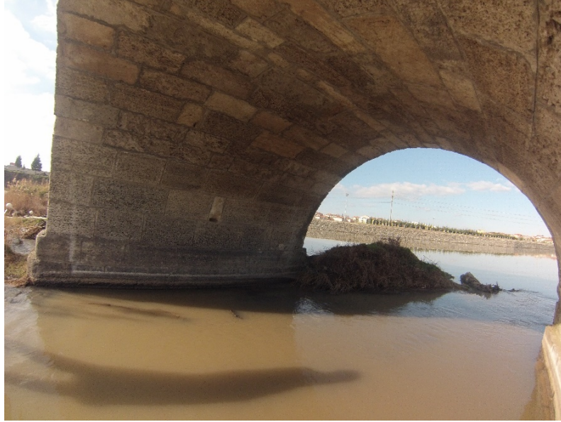
Şekil B.10: Büyükkarıştıran Köprüsü Kemer – 5 fotoğrafı
