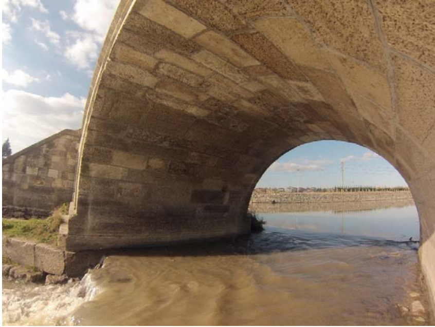
Şekil B.4: Büyükkarıştıran Köprüsü Kemer – 2 fotoğrafı
