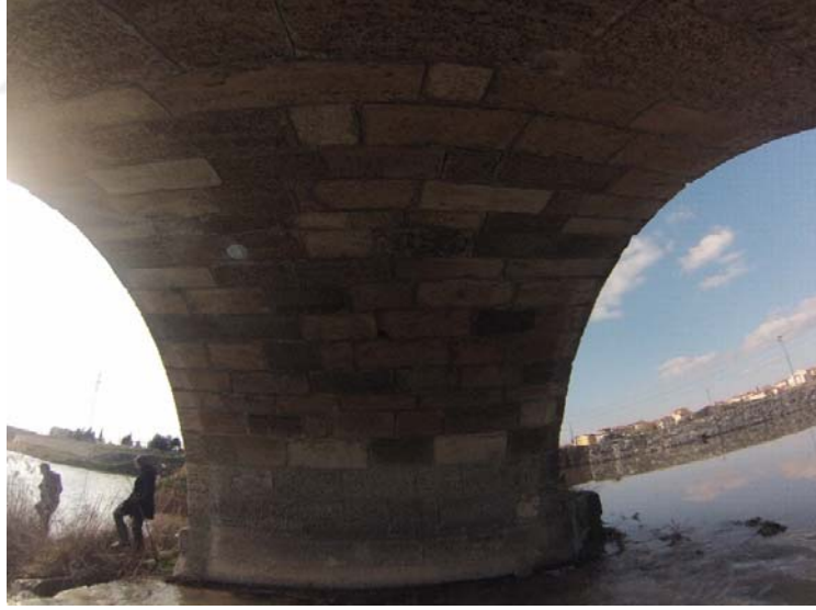
Şekil B.6: Büyükkarıştıran Köprüsü Kemer – 3 fotoğrafı
