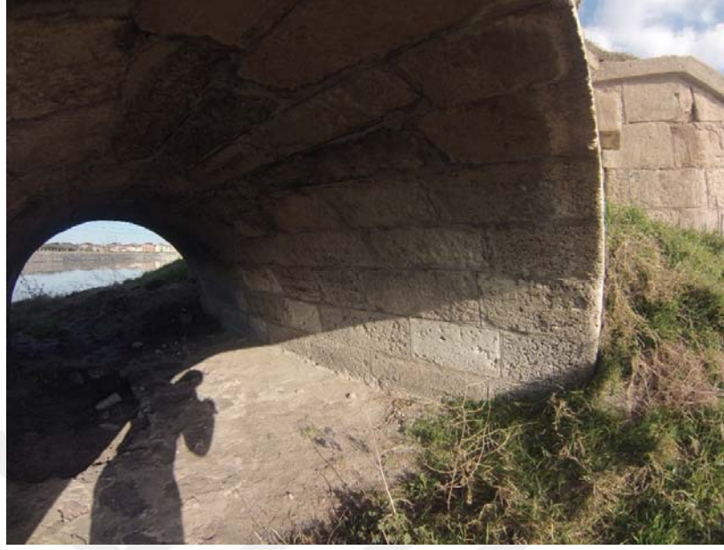
Şekil B.13: Büyükkarıştıran Köprüsü Kemer - 7 fotoğrafı
