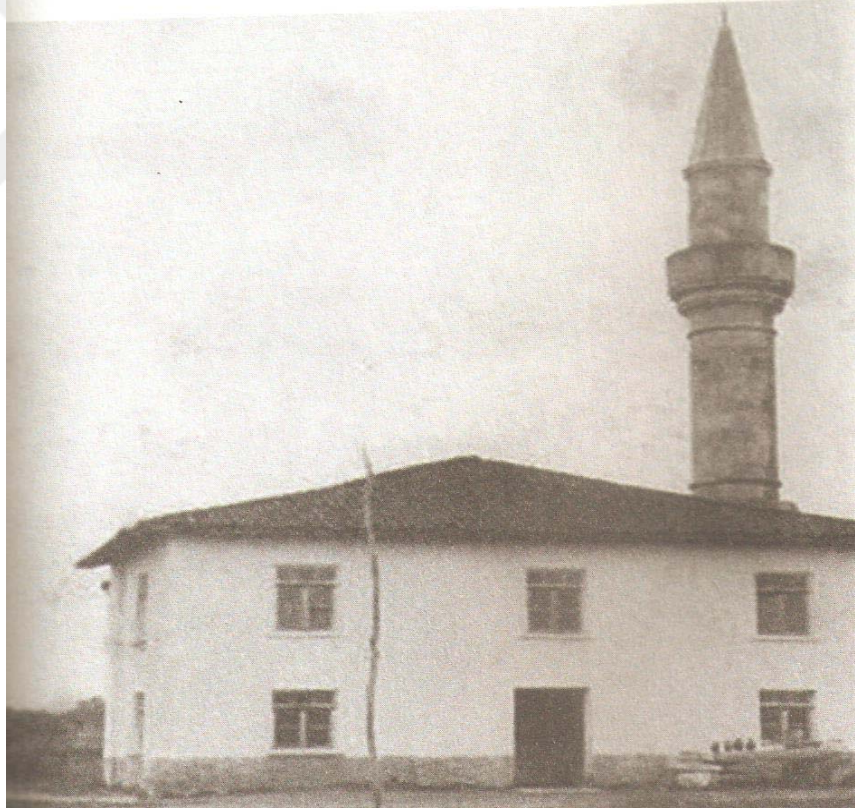
Şekil A.26: Büyükkarıştıran'da Rüstem Paşa Camii onarımı
