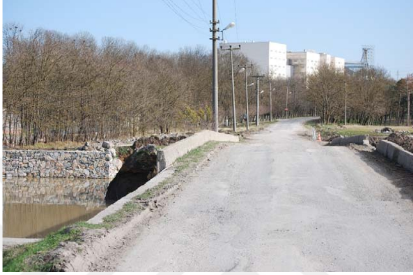
Şekil B.39: Büyükkarıştıran Köprüsü tabliye fotoğrafı
