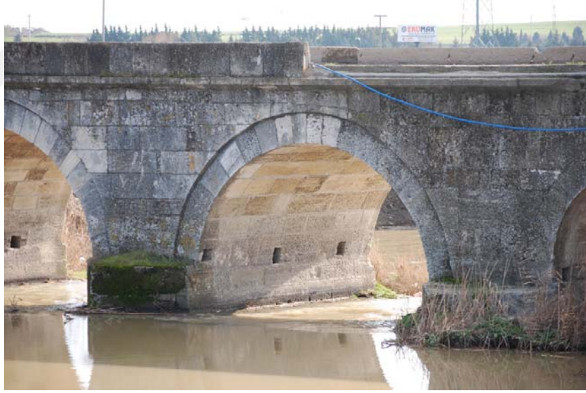
Şekil B.24: Büyükkarıştıran Köprüsü 4 No'lu ayak fotoğrafı
