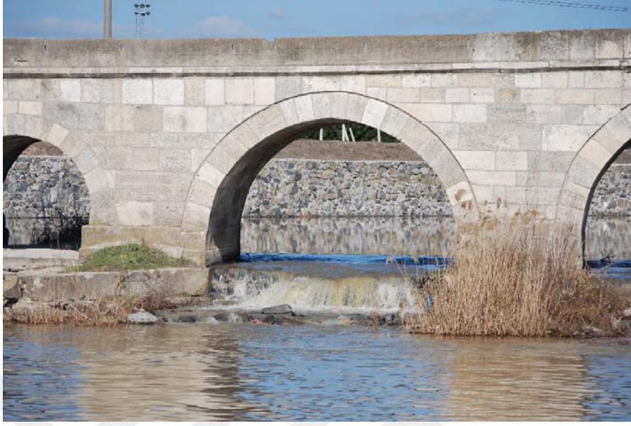
Şekil B.19: Büyükkarıştıran Köprüsü 2 No'lu ayak fotoğrafı
