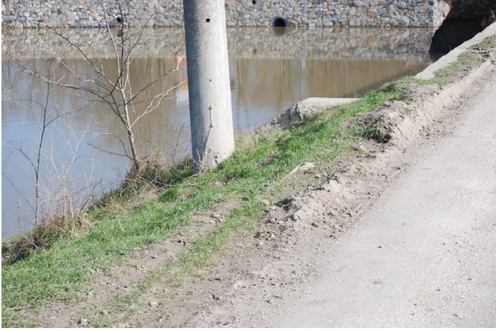
Şekil B.37: Büyükkarıştıran Köprüsü baba taşı yeri fotoğrafı
