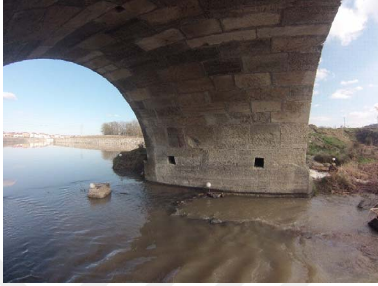
Şekil B.7: Büyükkarıştıran Köprüsü Kemer – 4 fotoğrafı
