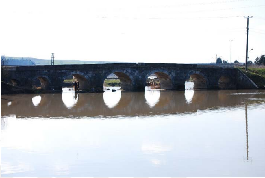
Şekil B.43: Büyükkarıştıran Köprüsü kuzey cephesi fotoğrafı
