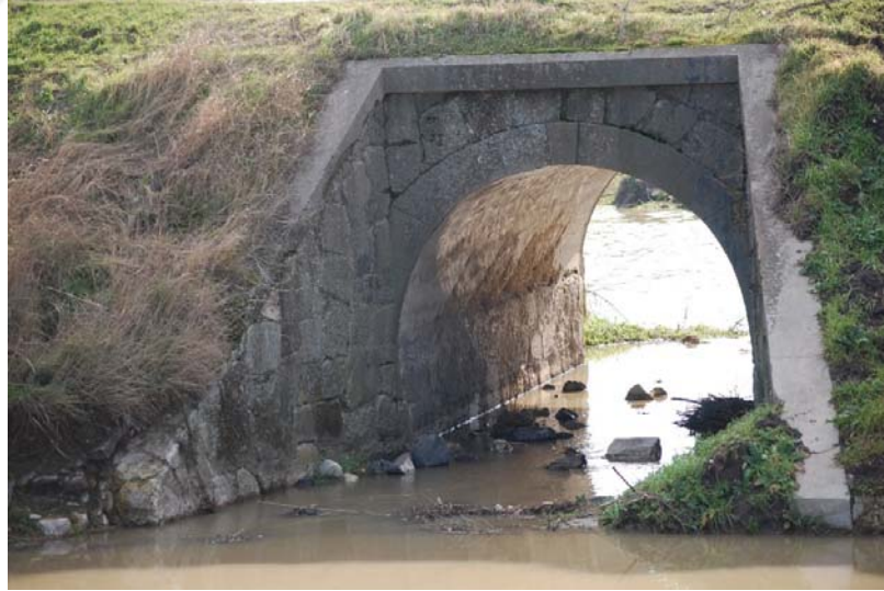
Şekil B.16: Büyükkarıştıran Köprüsü Kemer – 8 fotoğrafı
