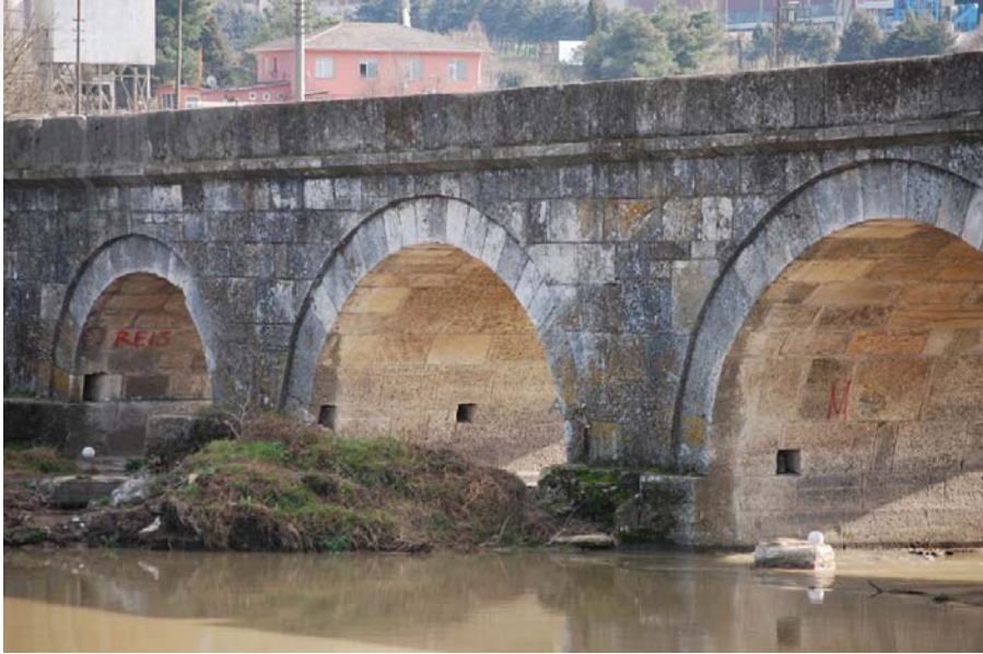
Şekil B.26: Büyükkarıştıran Köprüsü 5 No'lu ayak fotoğrafı
