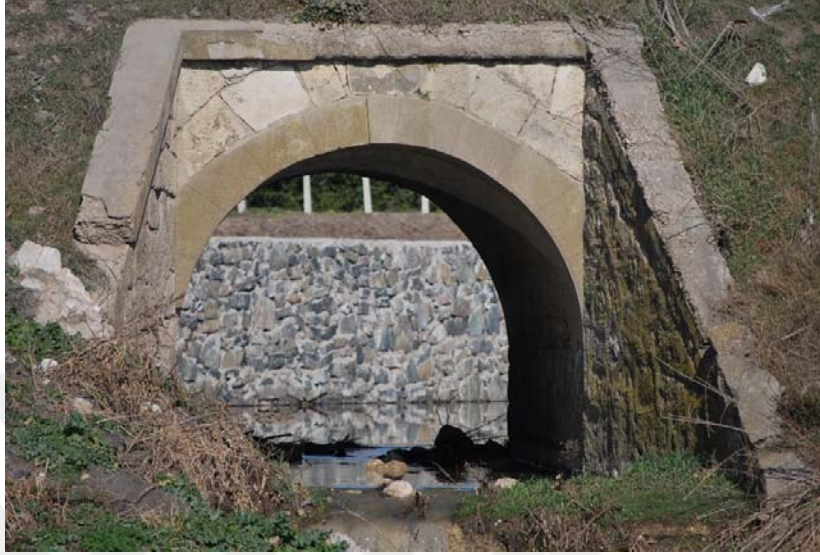
Şekil B.15: Büyükkarıştıran Köprüsü Kemer – 8 fotoğrafı
