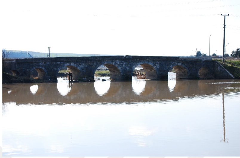
Şekil 3.5: Büyükkarıştıran köprüsü genel görünüşü
