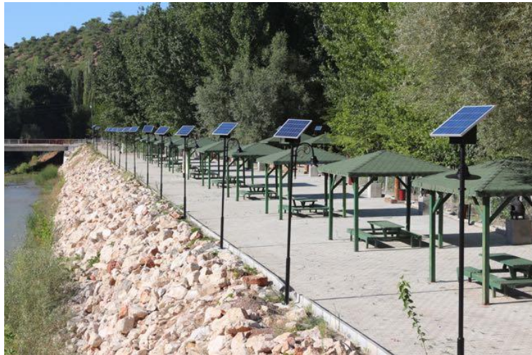
Şekil.5.23. Çorum Ortaköy ilçesinde İncesu kanyonunda kendi enerjisini üreten aydınlatma elemanları.
