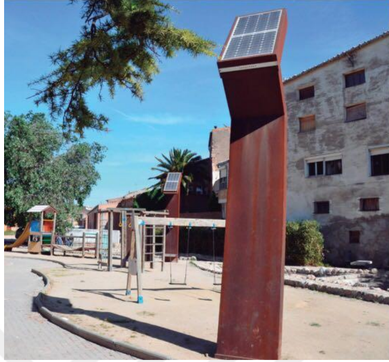
Şekil. 4. 40. İspanya Gandesa bölgesinde kendi elektriğini kendi üreten, korten çeliğinden üretilmiş sokak lambaları.
