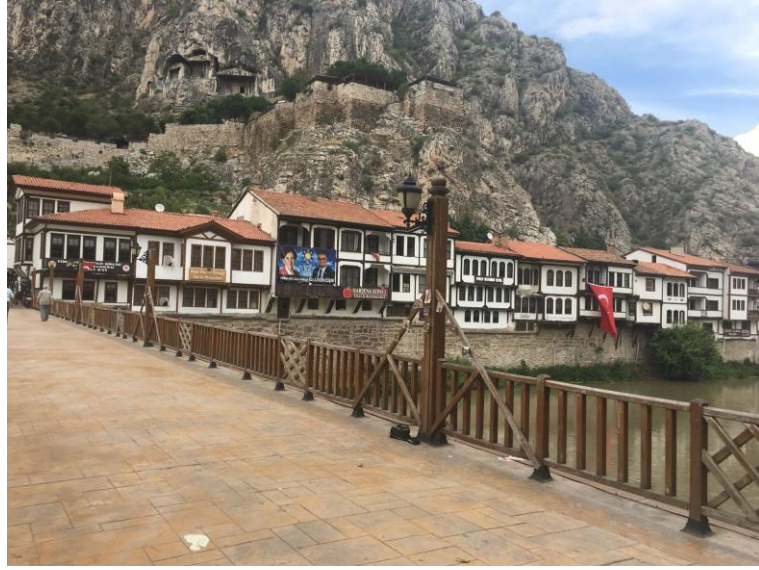
Şekil.5.27. Amasya da diğer bir örnek sokak lambası köprünün üstünde yürüme yolunda sınırlayıcı ile aynı malzeme kullanılması kent dokusuna uyumlu tasarlanmıştır.(Sevil Aydın Elmalı,2018)
