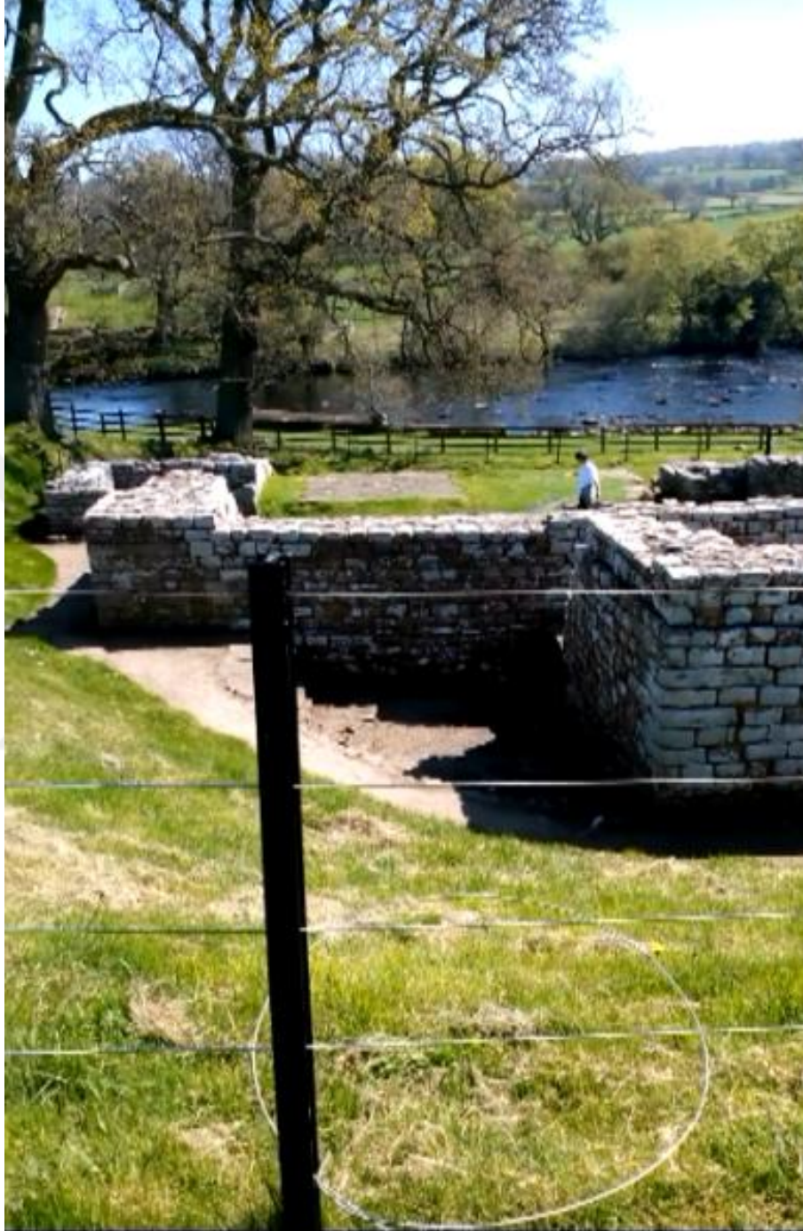
Fotoğraf 6.35 : Chesters Roma Kalesindeki Banyo duvarının sol köşe görünümü (Arzu UZUNOĞLU, 05.05.2018).
