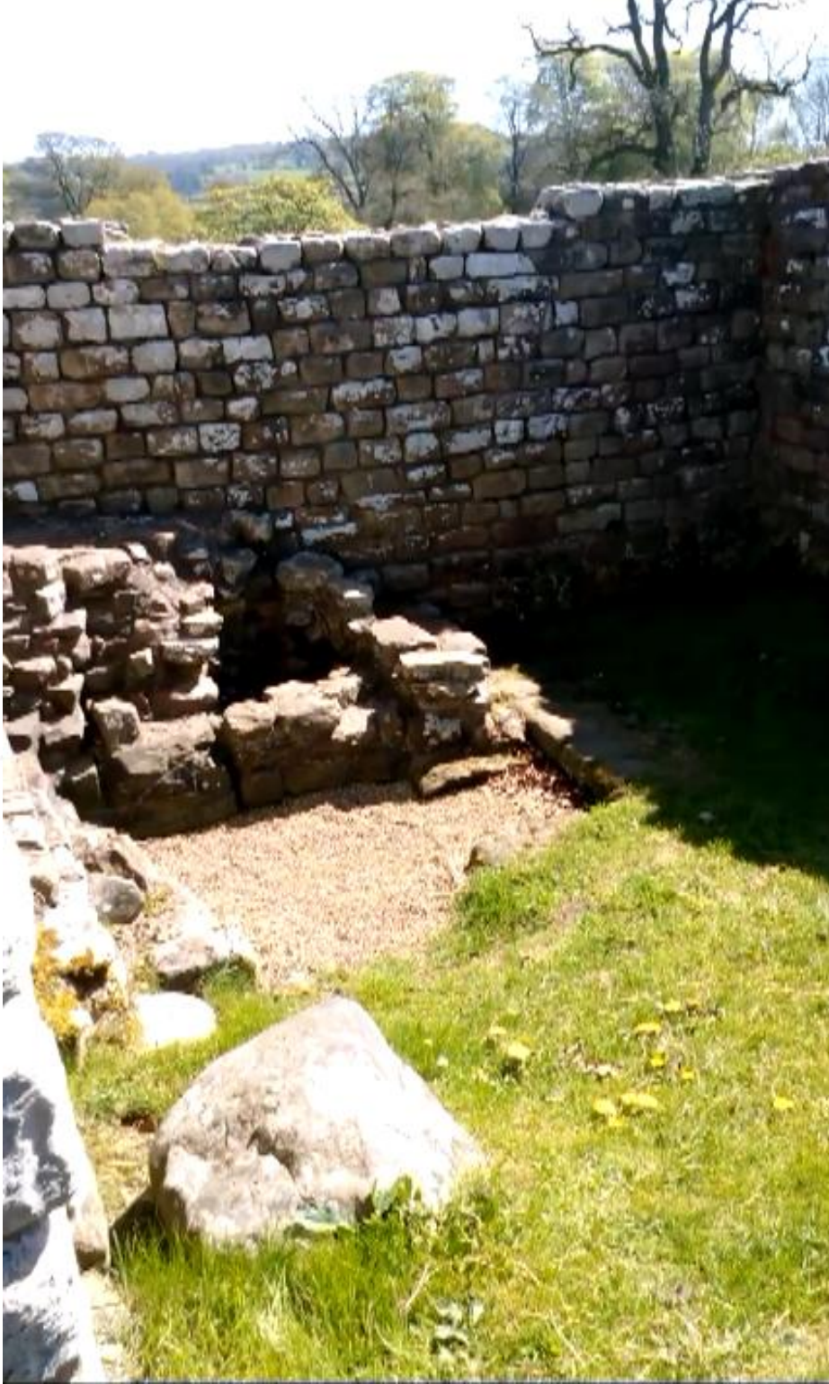
Fotoğraf 6.53 : Chesters Roma Kalesindeki Banyo duvarının bir görünümü (Arzu UZUNOĞLU, 05.05.2018).
