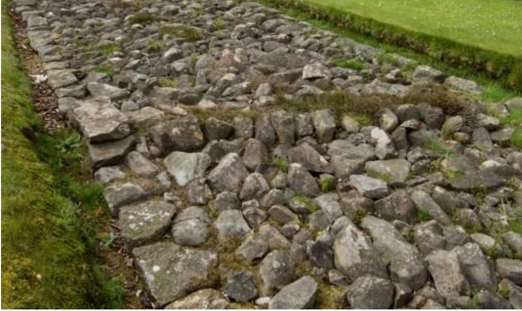
Şekil 1.1. Taş ile inşa edilen Çim Duvar (URL 6).
