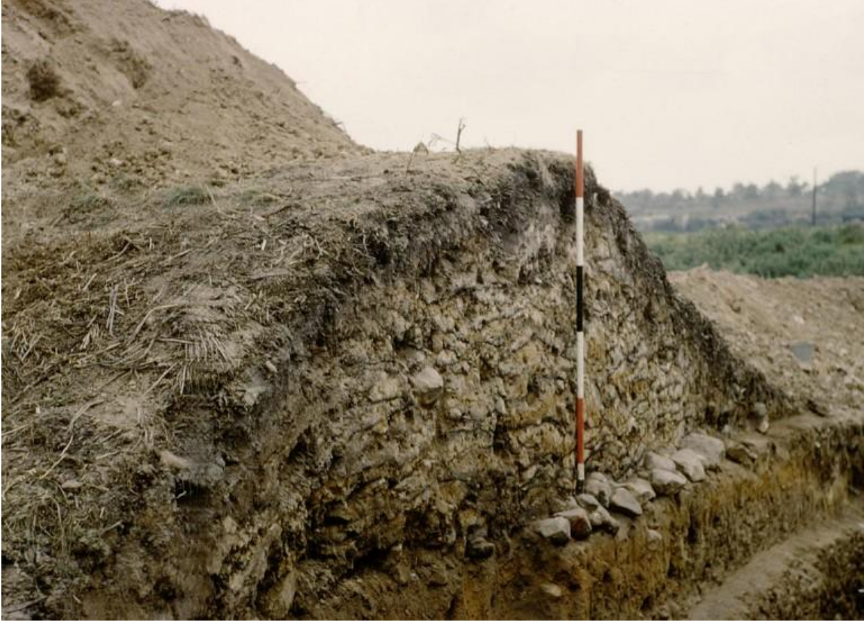
Şekil 1.2. Taş ile inşa edilen Çim Duvar (URL 6).
