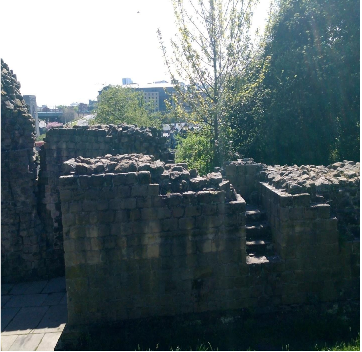
Fotoğraf 6.72 : Newcastle'daki koruyucu kale ve kalenin küçük bahçesinin duvar görünümü(Arzu UZUNOĞLU, 06.05.2018).
