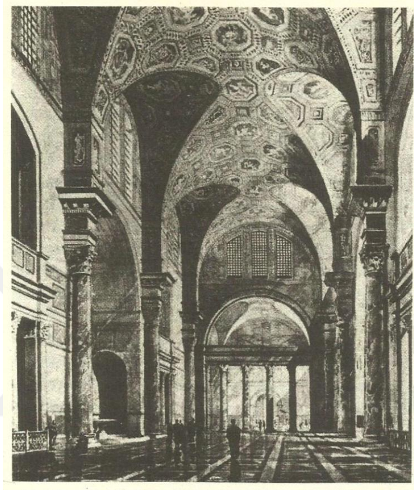
Şekil 7.2. Karakalla Hamamı iç görünümü (Roth, 2006: 323).
