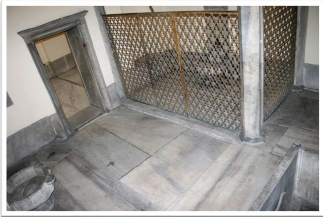
Şekil 48: Valide Sultan Hamamı, Sıcaklık Bölümü
