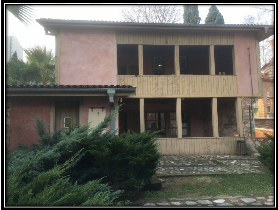
Şekil 3.76. Türk Evinin Restorasyon Sonrası İdari Binaya Dönüştürülmesi
