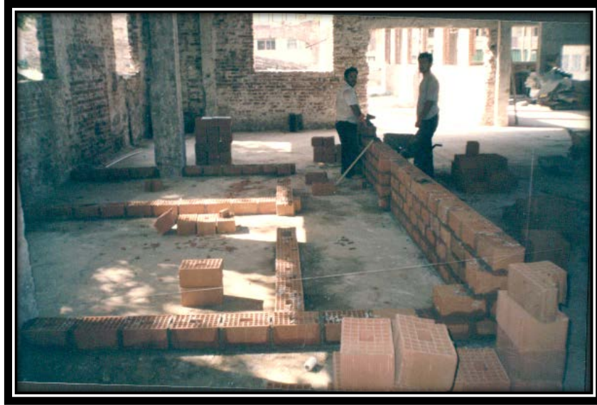
Şekil 3.41. Restorasyon Aşamasında Ana Bina İçerisindeki Tuğla Duvarlar Örüldürken
