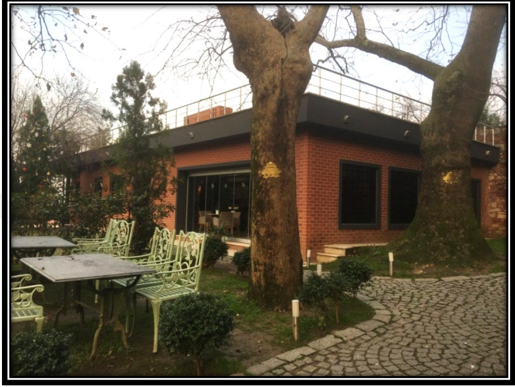
Şekil 3.72. Müştemilat Binası Restore Edilerek Kafeye Dönüştürülmesi
