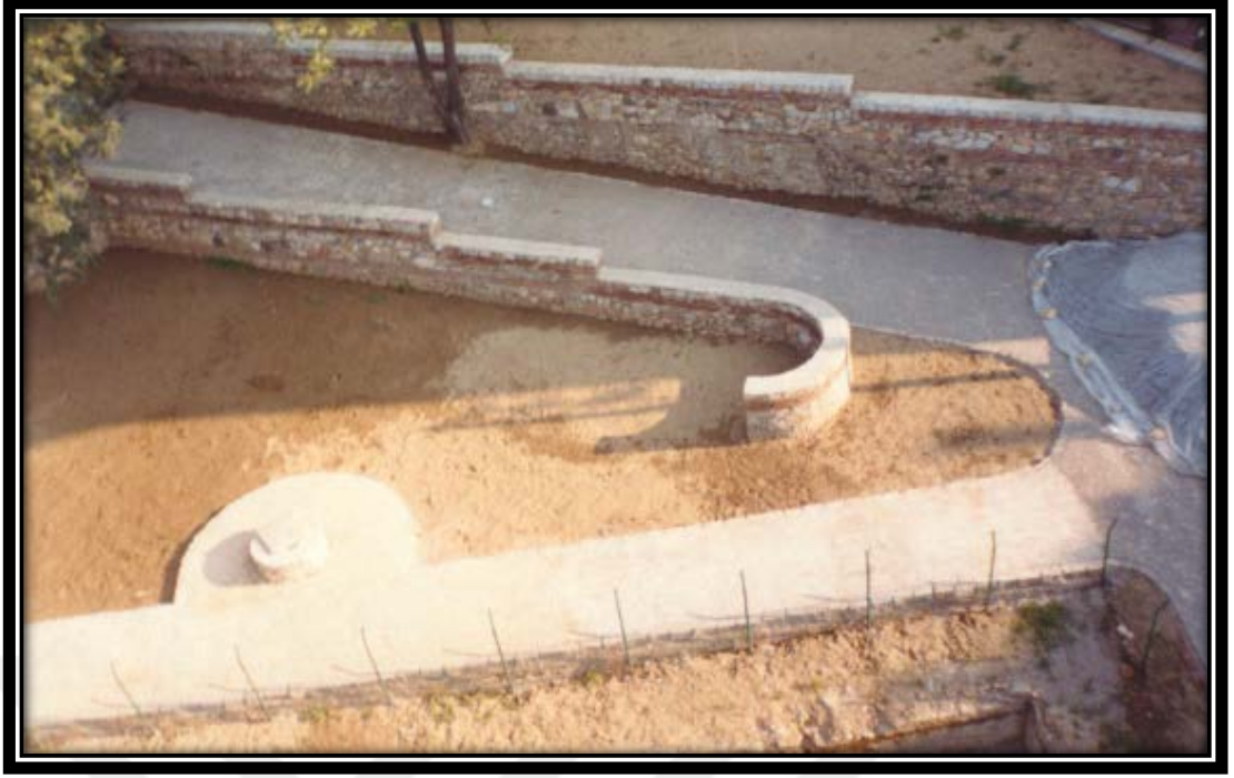
Şekil 3.90: Bahçe Yürüyüş Yolları ve Kaldırımlar Yapılırken, Nisan 2000
