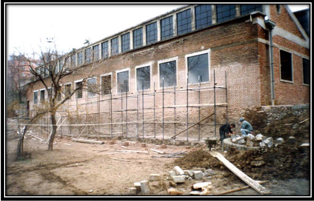
Şekil 3.49. Ana Bina Cephesinin Güçlendirme ve Restorasyon Aşaması -1
