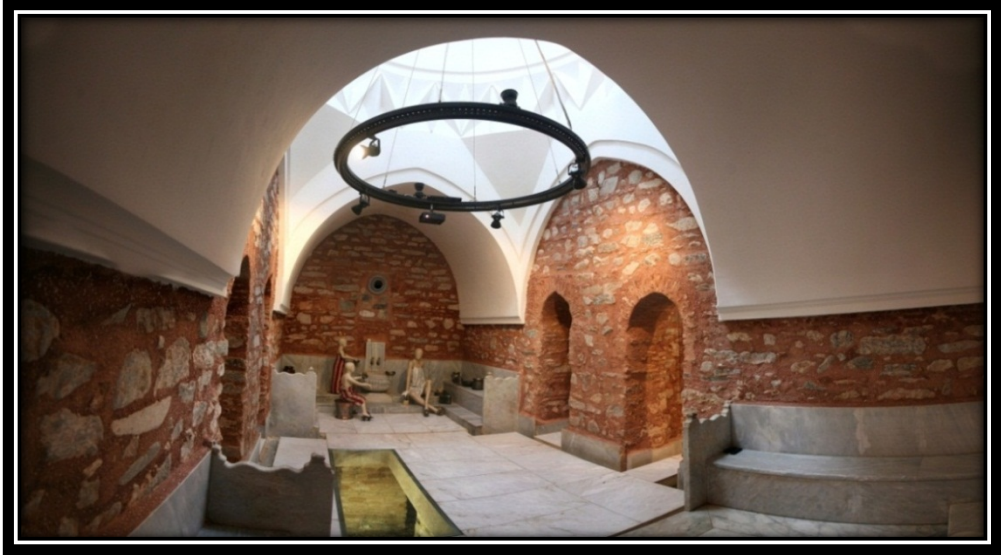
Şekil 3.62. Restorasyon Sonrası Sıcaklıktan Görünüş
