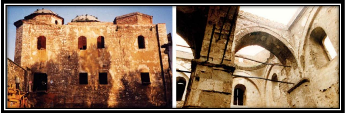
Şekil 2.21. Lengerhane Binası Restorasyon Aşaması
