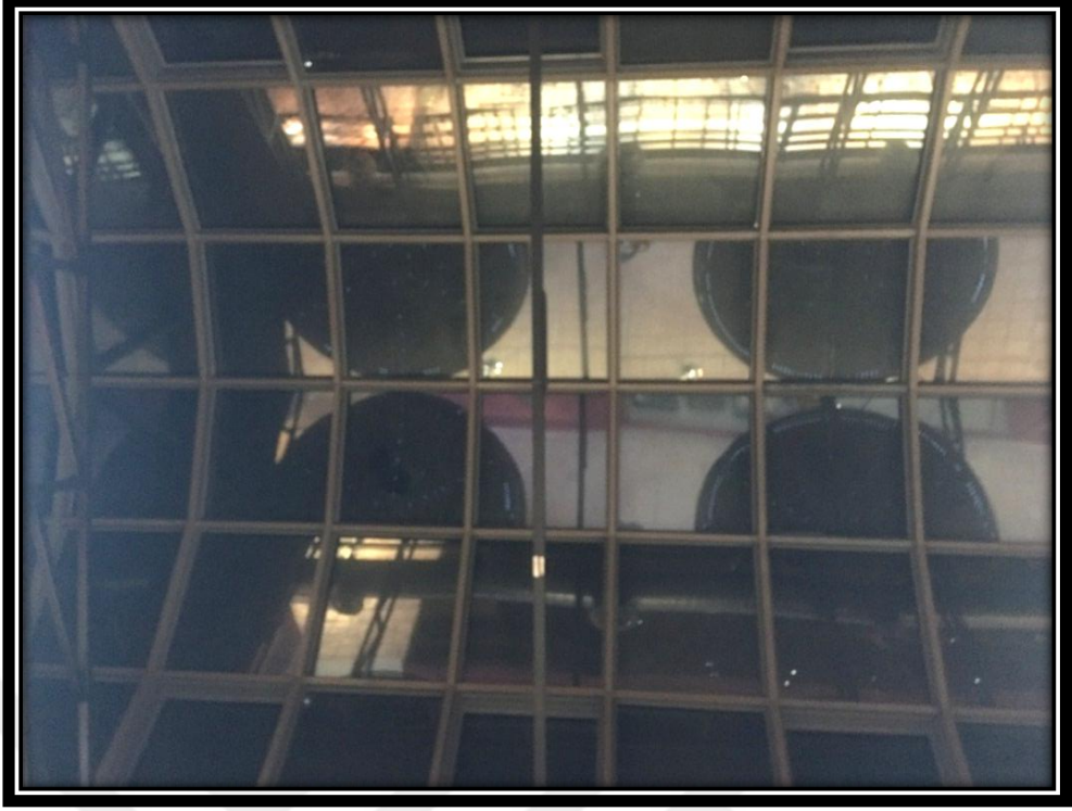
Şekil 3.67. İlave Yapılan Fuaye Salonunun Cam Tavanından Görünüş
