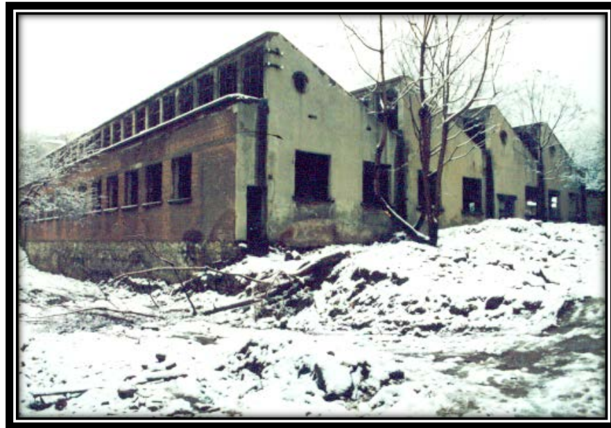
Şekil 3.38. Restorasyon Öncesi Terkedilmiş Fabrika Binasından Görünüş
