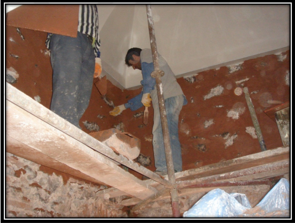
Şekil 3.57. Hamam İçi Restorasyon Aşaması – Derzlerin Yapılması
