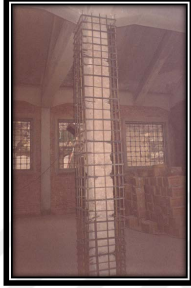
Şekil 3.47. Restorasyon Aşamasında Ana Bina'daki Kolon Ebatlarının Büyütülmesi, Kasım 2000
