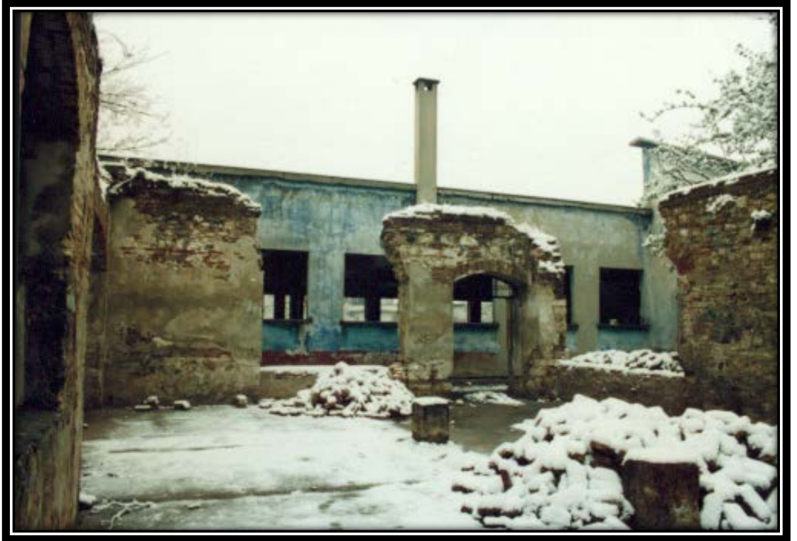
Şekil 3.32. Mancinkhane Binası Restorasyon Öncesi Durum Kaynak: Tofaş Anadolu Araba Müzesi Arşivinden Temin Edildi
