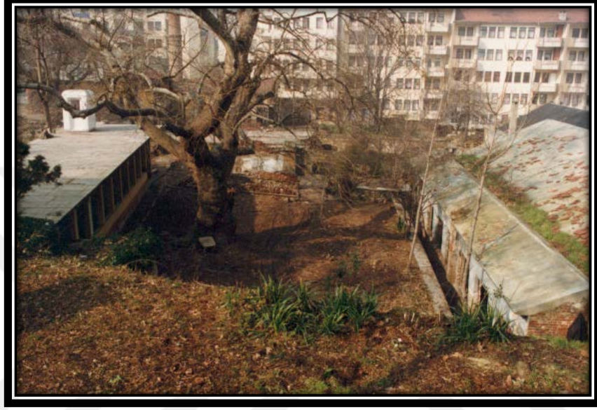
Şekil 3.45. Restorasyon Öncesi Terkedilmiş Fabrika Binası Çatısından Görünüş
