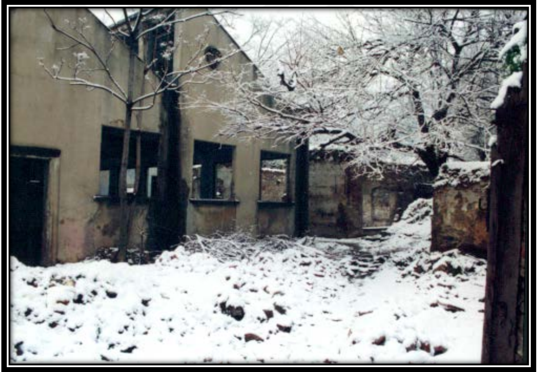
Şekil 3.39. Restorasyon Öncesi Terk Edilmiş Binanın Çalınan Camlarından Görünüş
