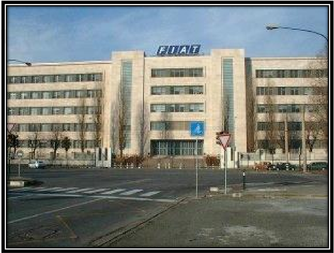
Şekil 2.8. Fiat Fabrikasının Dışarıdan Görünüşü
