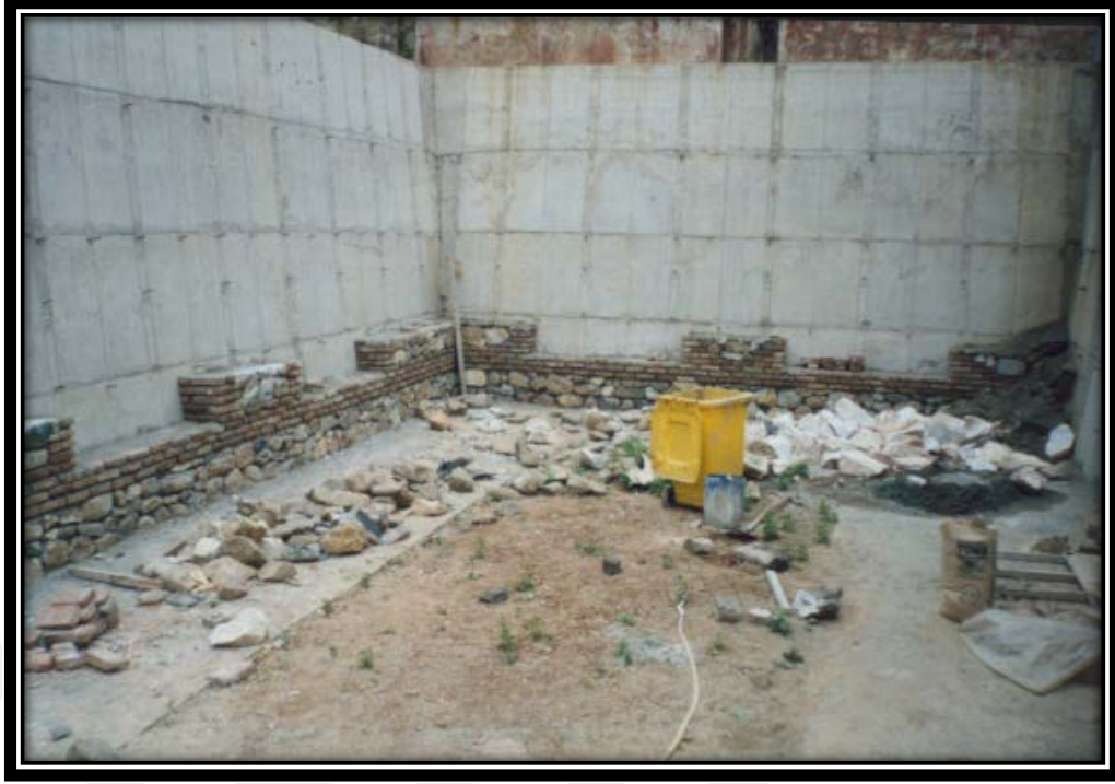
Şekil 3.33. Yıkılan Mancımkhane Binası Restore Edilirken Kaynak: Tofaş Anadolu Araba Müzesi Arşivinden Temin Edildi
