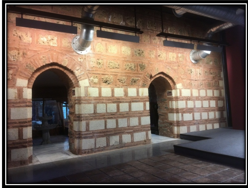
Şekil 3.55. Bekleme Alanından Hamam-Soğukluk Kısına Geçiş
