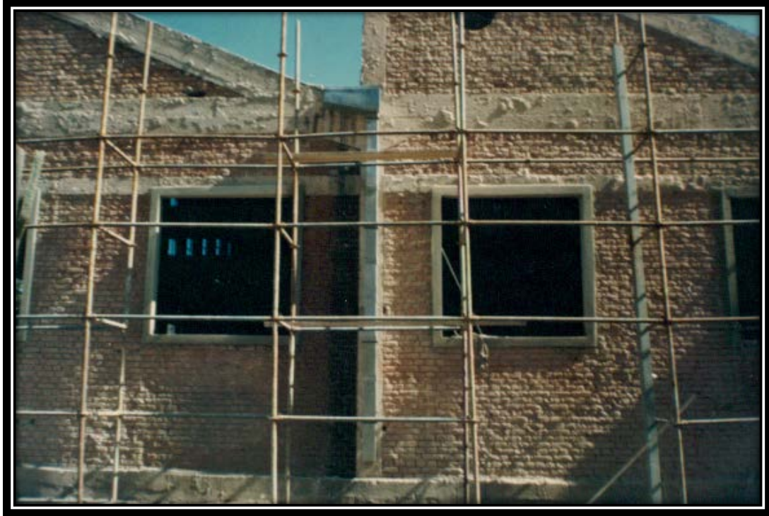
Şekil 3.50. Ana Bina Cephesinin Güçlendirme ve Restorasyon Aşaması -2
