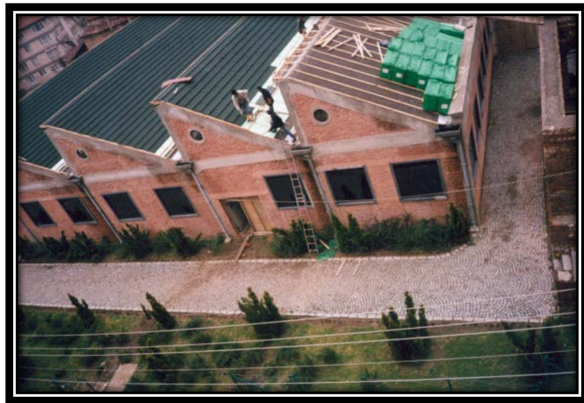
Şekil 3.46. Ana Bina Çatısı Restore Edilirken
