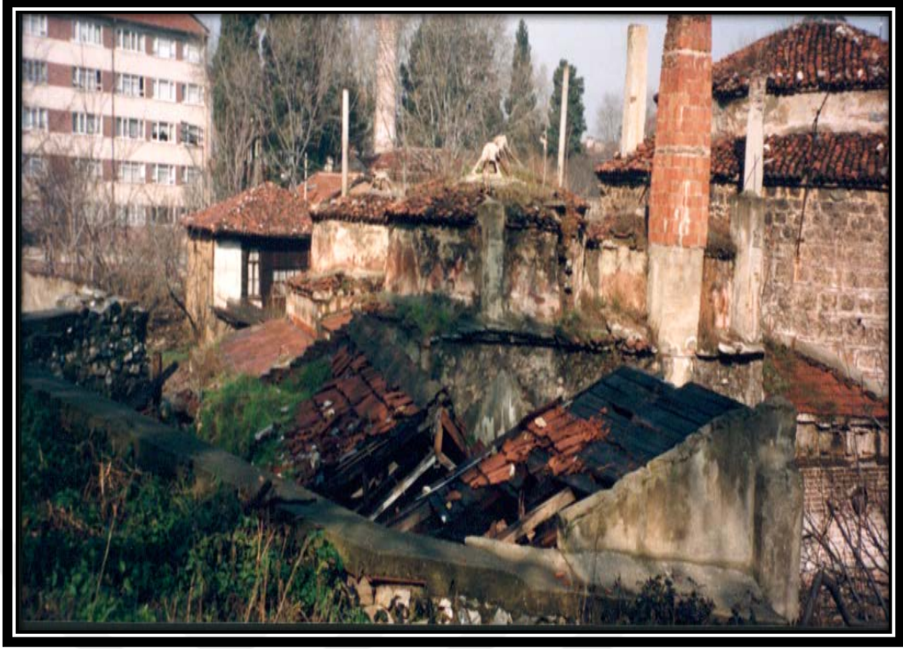
Şekil 3.58. Restore Edilmeden Önce Hamamın Çatısından Görünüş
