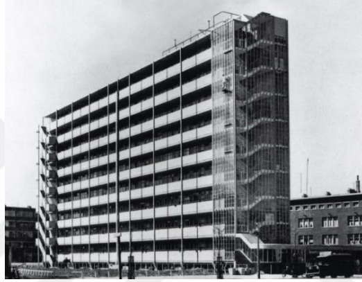
Şekil 3.8.2.6. J. Brinkman, Leendert van der Vlugt, Willem van Tijen Apartman Bloğu 1933-34
