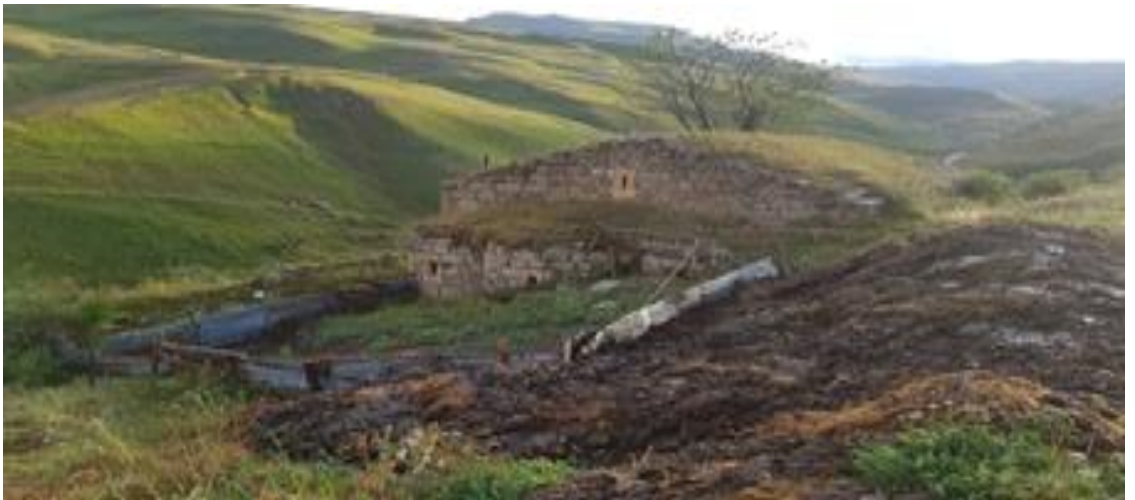
Şekil 3. 49. Meryem Ana I Kilisesi’nin Dıştan Görünüşü
