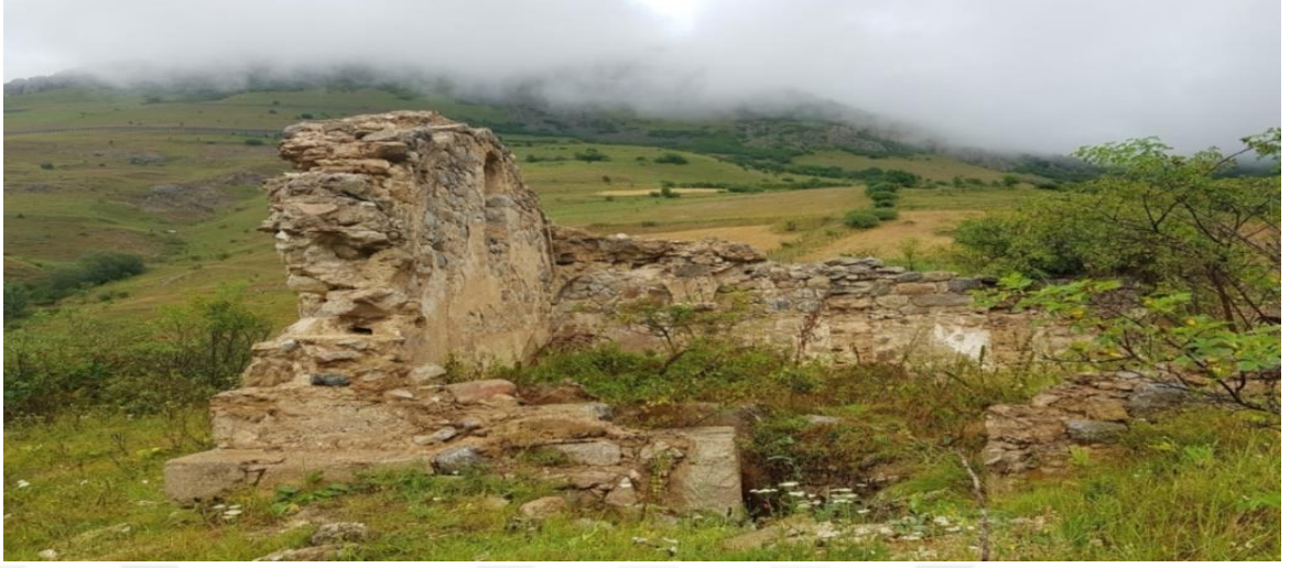
Şekil 3. 48. Söğüteli Köyü’nde Yer Alan Yıkık Kilise
