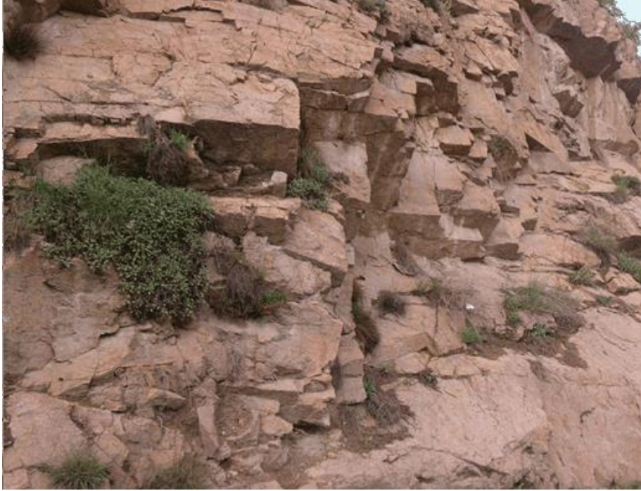
Şekil 3.4. Eski Gümüşhane'deki Gümüşhane Granitoidi'nin çatlaklı yapısının çalışma alanındaki görünümü
