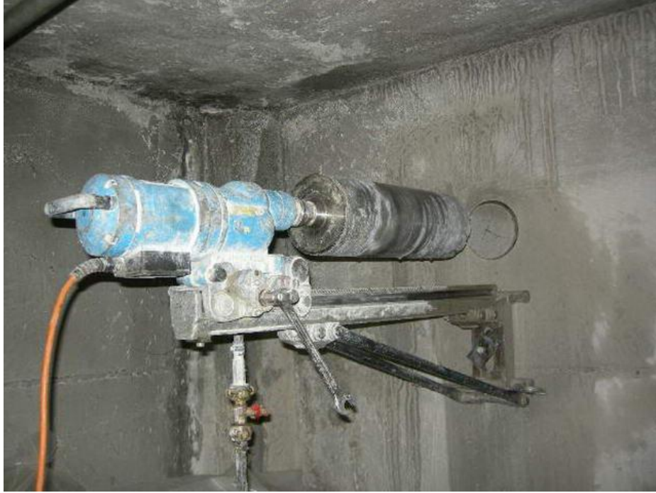
Şekil 1.3. Betonarme kesitten karot alınması
