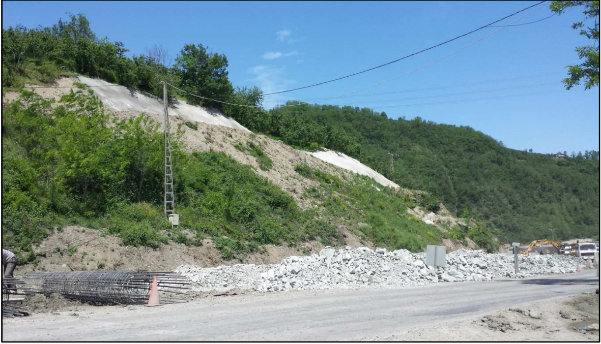
Şekil 5.1. Karayolları 10. Bölge müdürlüğünce heyelan bölgesinde yapılan çalışmalar
