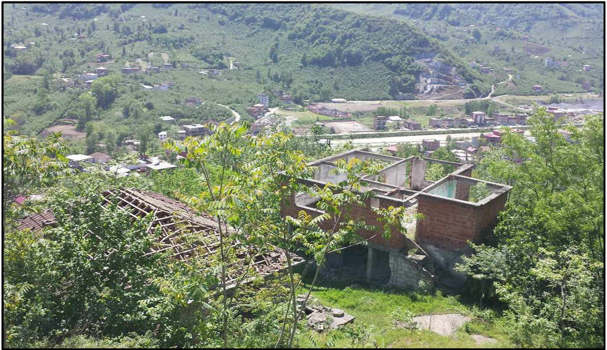
Şekil 4.7. Oluşan afet nedeniyle boşaltılan konutlar
