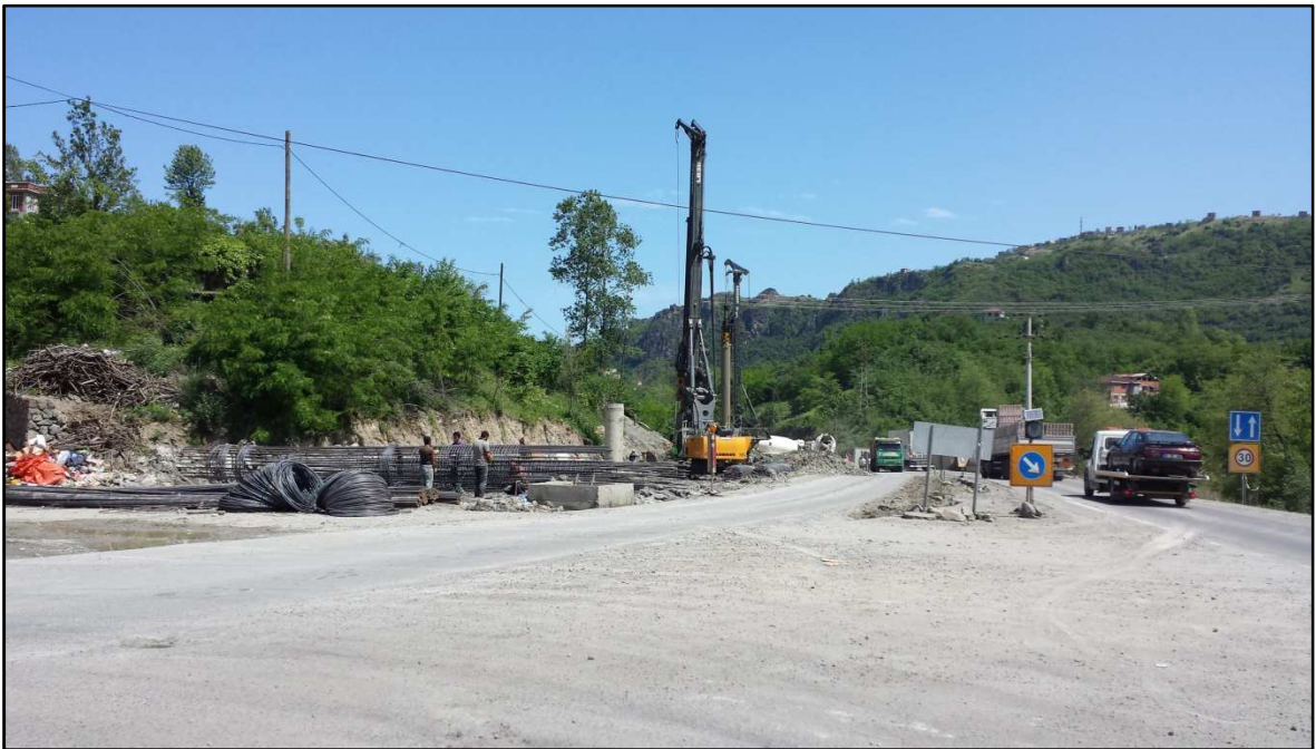
Şekil 5.2. Karayolları 10. Bölge müdürlüğünce heyelan bölgesinde yapılan çalışmalar
