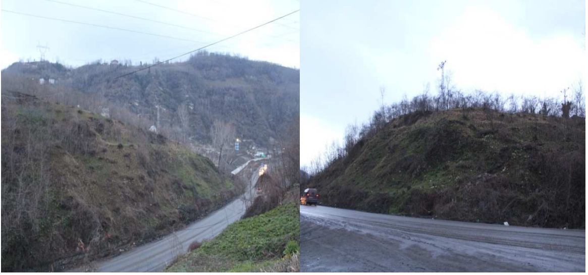
Şekil 4.6. Mevcut karayolu ve heyelan topuk bölgesi
