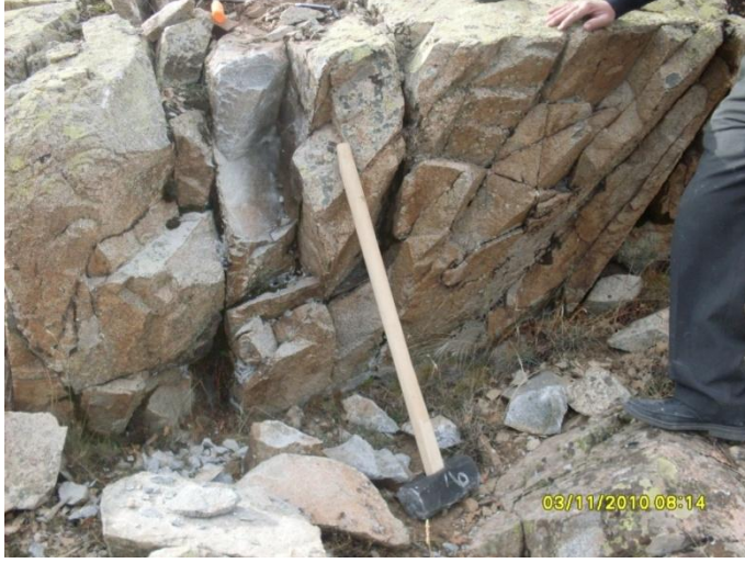
Şekil 3.9. Kılıçkaya Granitoyidi'ne ait çatlaklı yapılar (Yer: Kureşkabanı Tepe güneyi)
