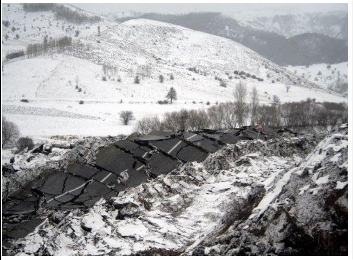
Şekil 2.7. Ulaşımı tehdit eden, Gümüşhane yakınlarında meydana gelen heyelan ( http://galeri.haberturk.com/gundem/galeri/420572-heyelen-yolu-kapatti/1/4. )
