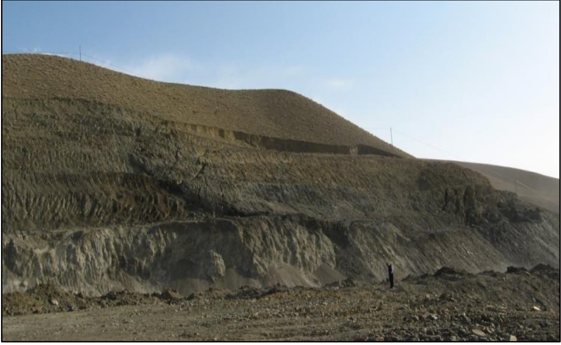
Şekil 1.13. Van-Hakkari devlet yolu dönel kayma heyelanı
