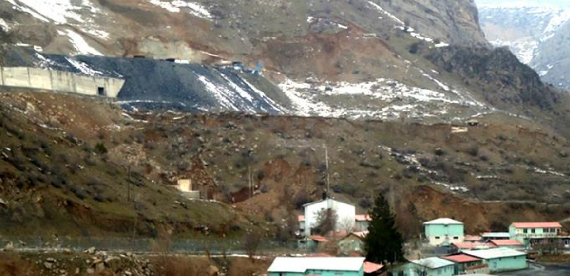
Şekil 1.21. Çukurca tüneli portalında gerçekleşen sürşarj yüküne bağlı heyelan
