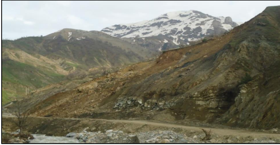
Şekil 1.18. Mutki-Geyikpınar yolu akma heyelanı
