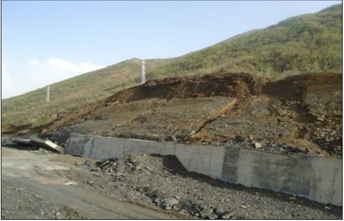
Şekil 1.14. Çukurca güvenlik yolunda bir blok (düzlemsel) kayma heyelanı
