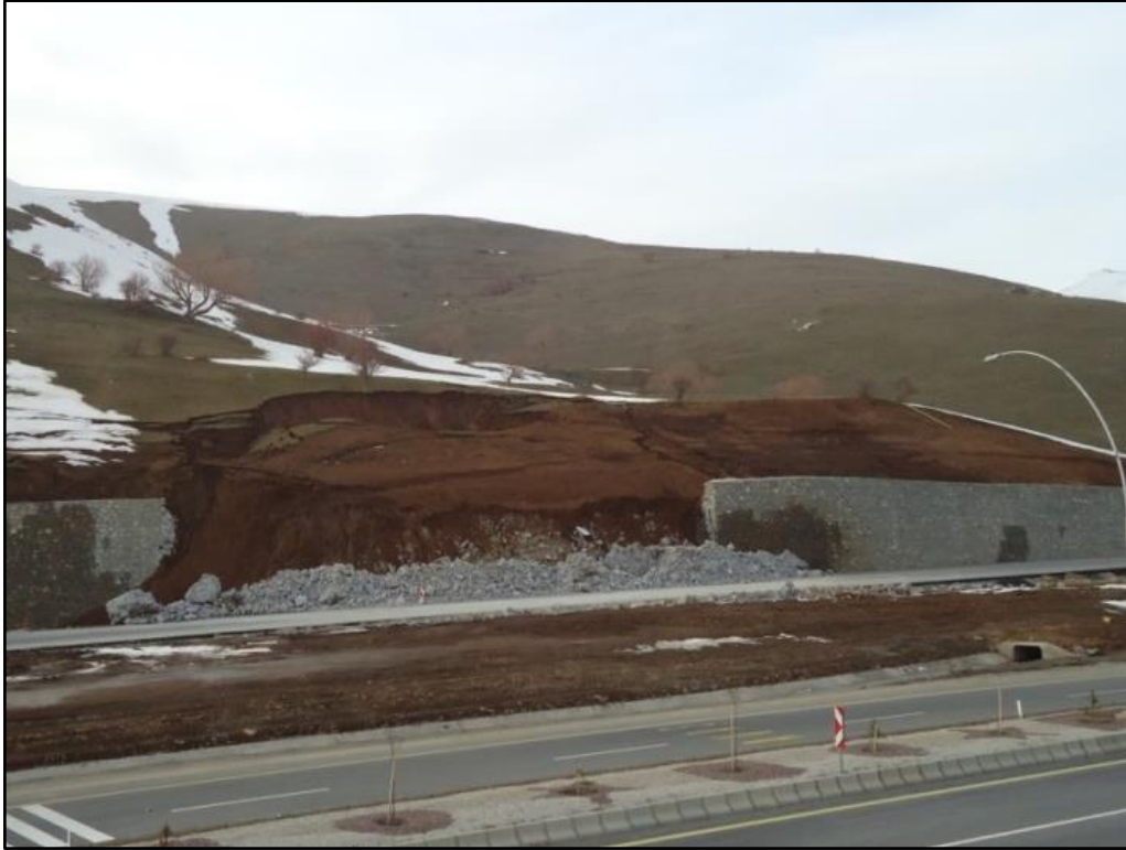
Şekil 1.12. Van-Tatvan devlet yolu döne kayma heyelanı
