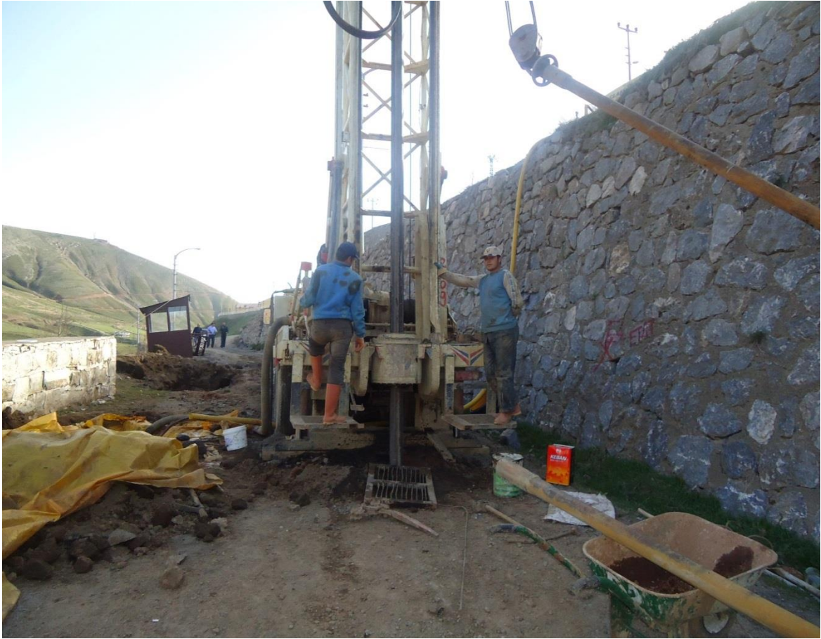
Şekil 1.28. Bitlis Batarya kavşağı heyelan alanı sondaj çalışması
