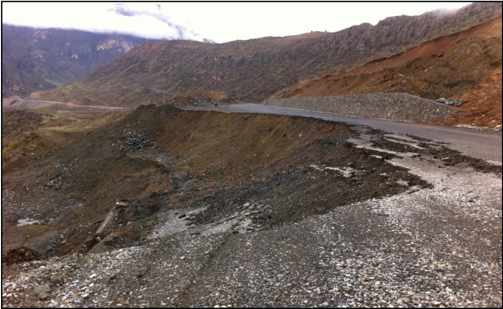
Şekil 1.26. Çukurca güvenlik yolunda eğimli araziye oturan dolgudaki heyelan
