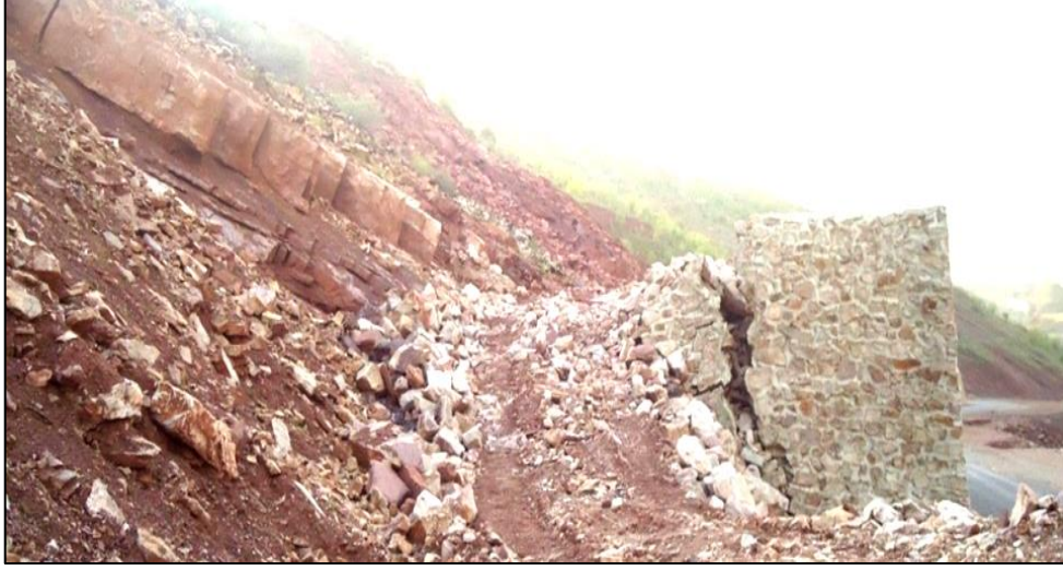
Şekil 1.22. Çukurca il yolunda olumsuz yönde tabakalanma sonucu heyelan
