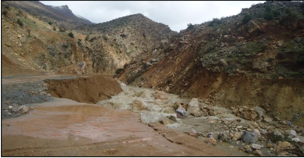
Şekil 1.23. Mutki-Meydan yolu dere oyması heyelanı
