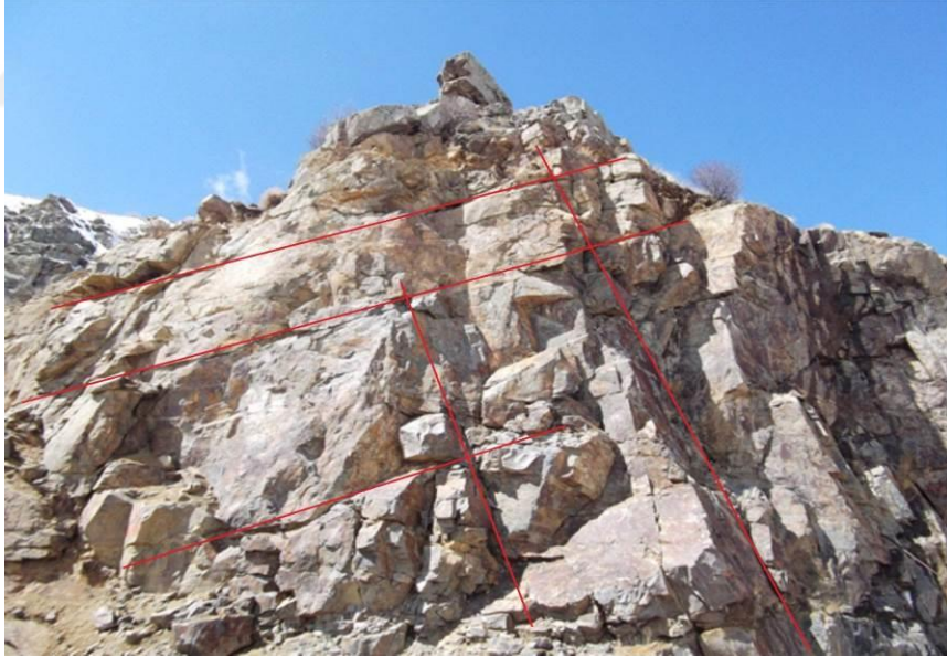
Şekil 3.12. Granitoyid kütlelerinde gözlenen çatlak sistemleri
