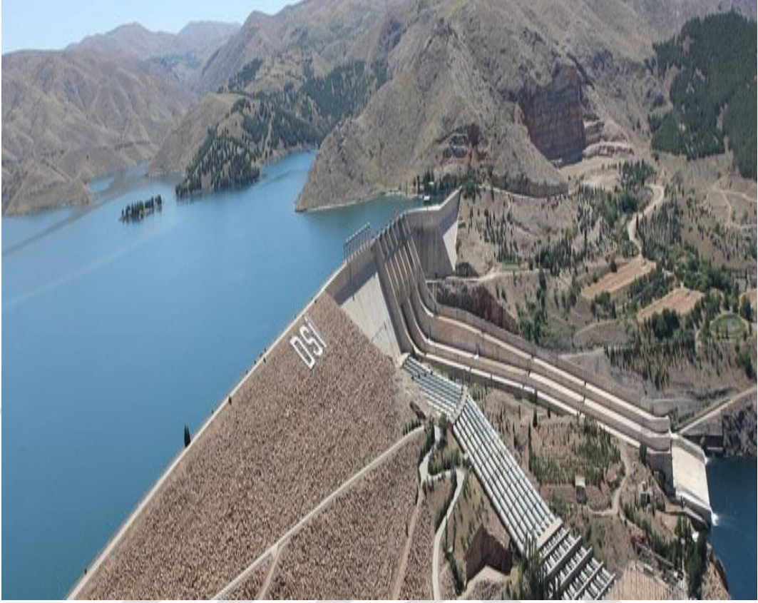
Şekil 1.1. Keban Barajı gövde görünümü
