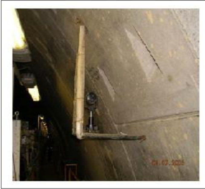
Şekil 1.5. Tünel Duvarında Poligon Noktası Tesisi (Ünlütepe, 2005).
