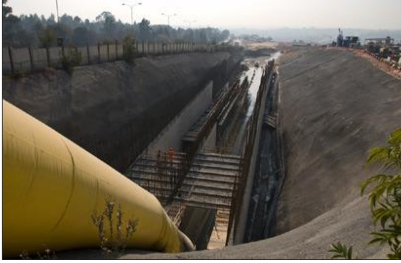
Şekil 1.6. Aç-Kapa Yöntemi ile Tünel açma çalışması (Gengeç, 2010)
