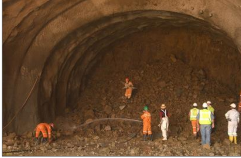
Şekil 1.8. Del Patlat Yöntemi ile Tünelde Patlama Sonrası (Gengeç, 2010).
