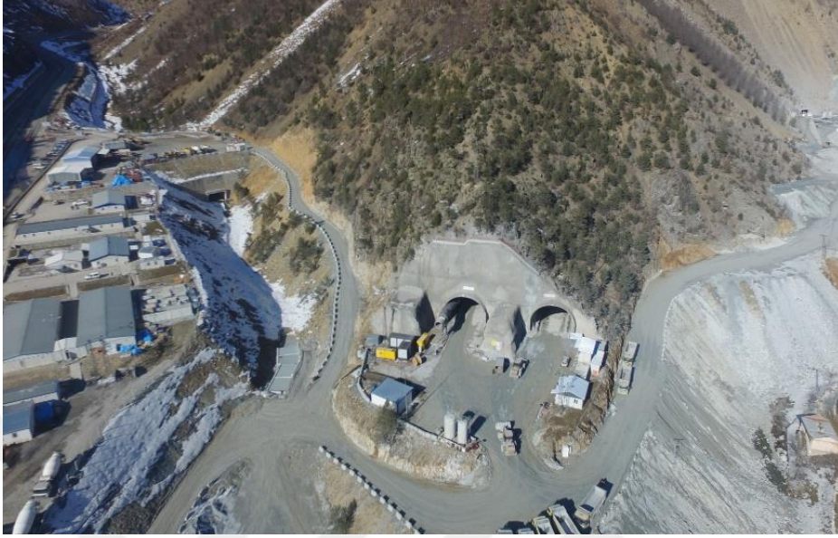
Şekil 2.8. Yeni Zigana Tüneli Giriş Fotoğrafı
