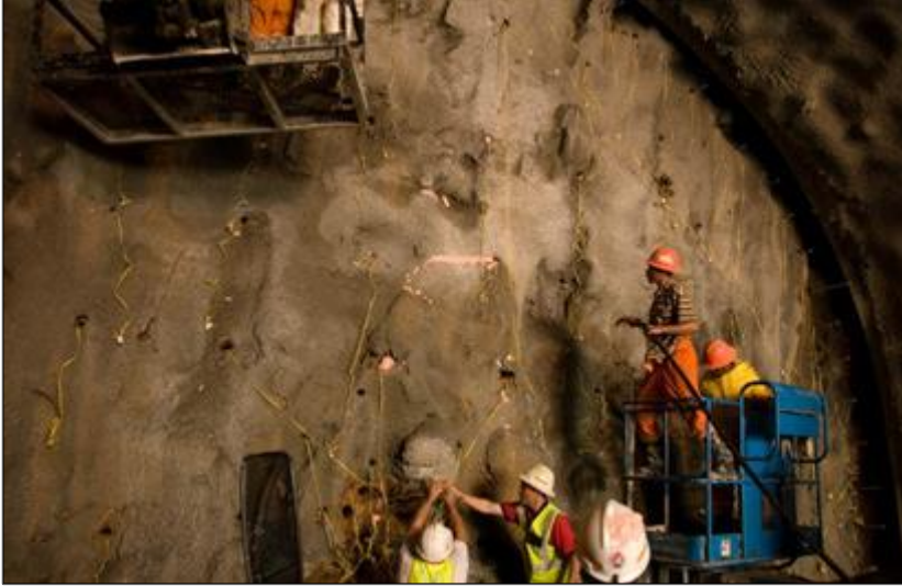
Şekil 1.7. Del Patlat Yöntemi ile Tünele Patlayıcı Yerleştirilmesi (Gengeç, 2010).
