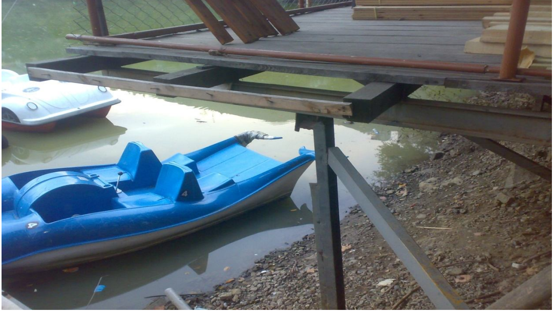
Şekil 2.4. 2. İstasyona Ait Genel Görünüm
