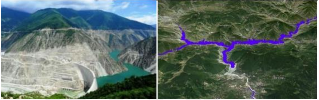
Őekil 2.3. Deriner Barajı’nın gvde kısmı ile su tutulma ařamasından sonra oluřan rezervuar alanından grnm
