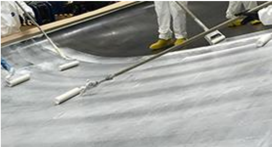
Şekil 2.20 Rulolar ile yapılan yüzey işlemi [56]
