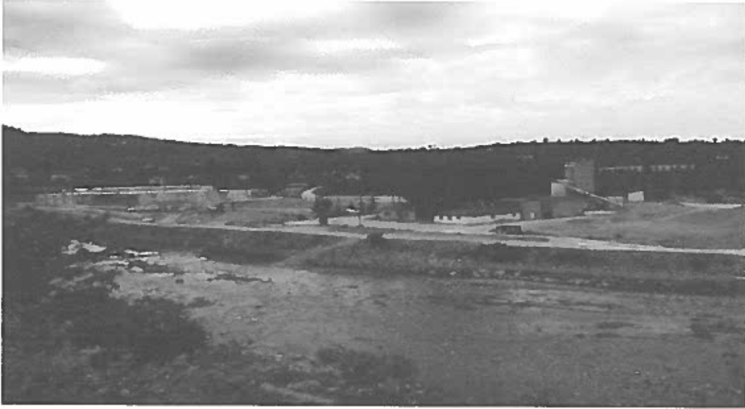
Şekil 5.1 Akçaova Deresi Üzerindeki Beton Santrali
