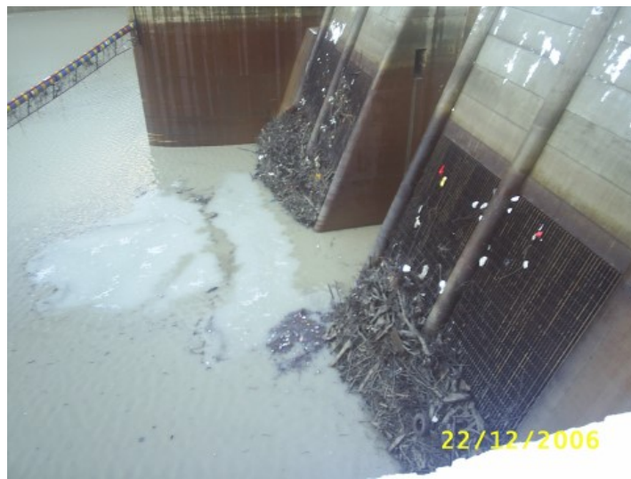
Şekil 2.2. Su Alma Tesisi
