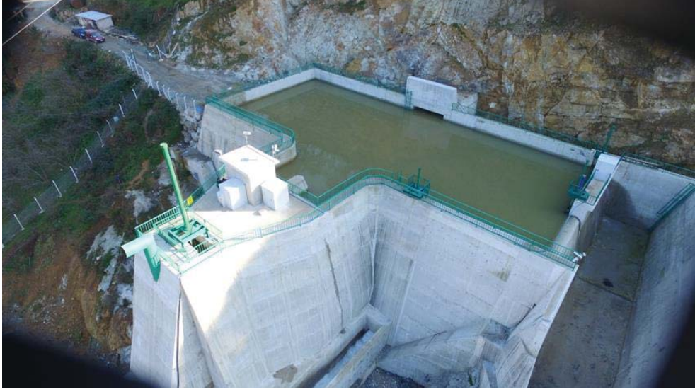
Şekil 3.3. Yumrutepe HES yükleme havuzu
