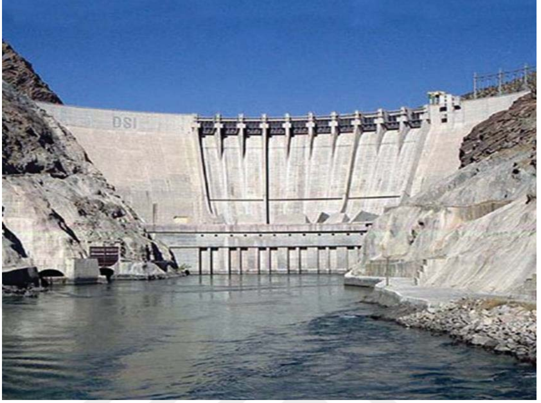
Şekil 2.15. Barajlı hidroelektrik santral (Karakaya HES) [25]
