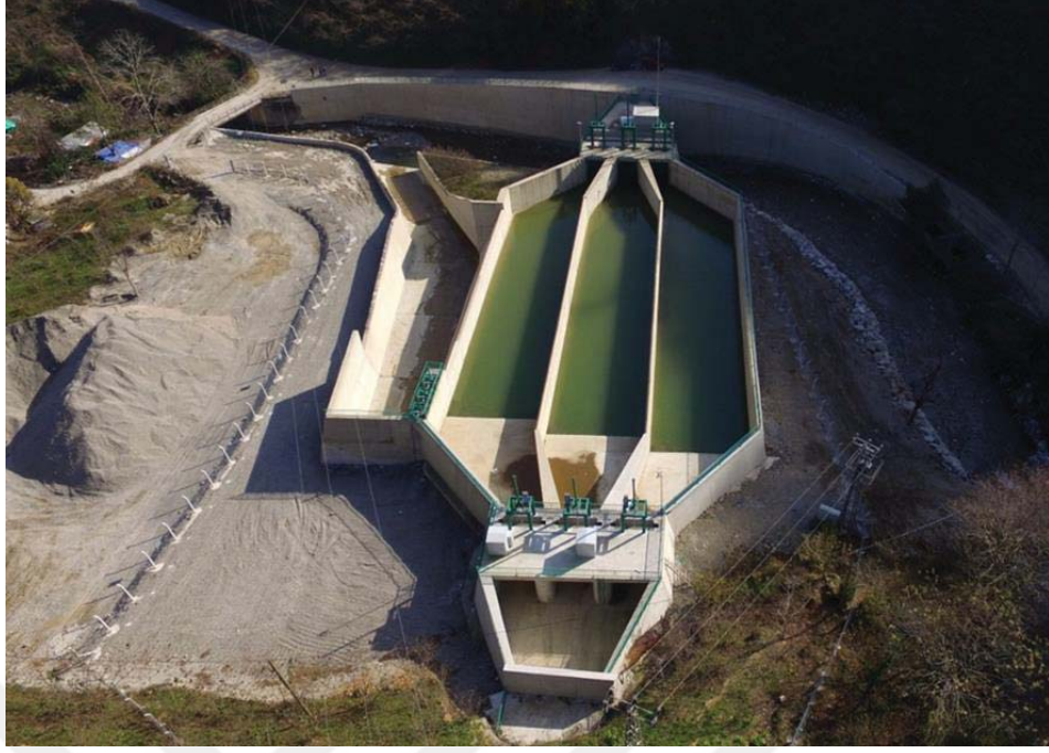
Şekil 3.2. Yumrutepe HES çökeltim havuzu
