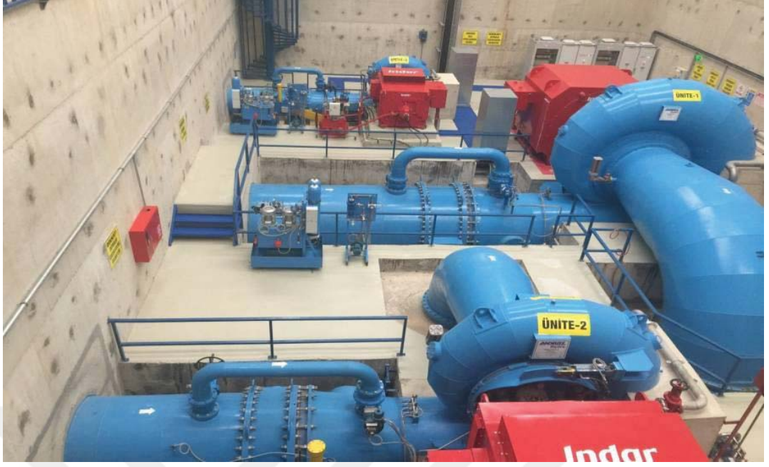
Şekil 2.22. Yatay eksenli salyangoz şeklinde francis türbin [46]
