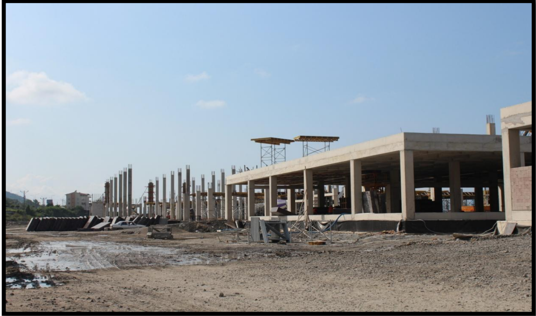
Fotoğraf 4.15. Üstyapı İnşaatından Genel Bir Görünüm (25.08.2014).
