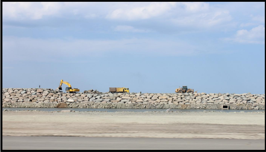
Fotoğraf 4.2. Dış Koruyucu Mendireği Yükseltme Çalışmaları (18.04.2014).
