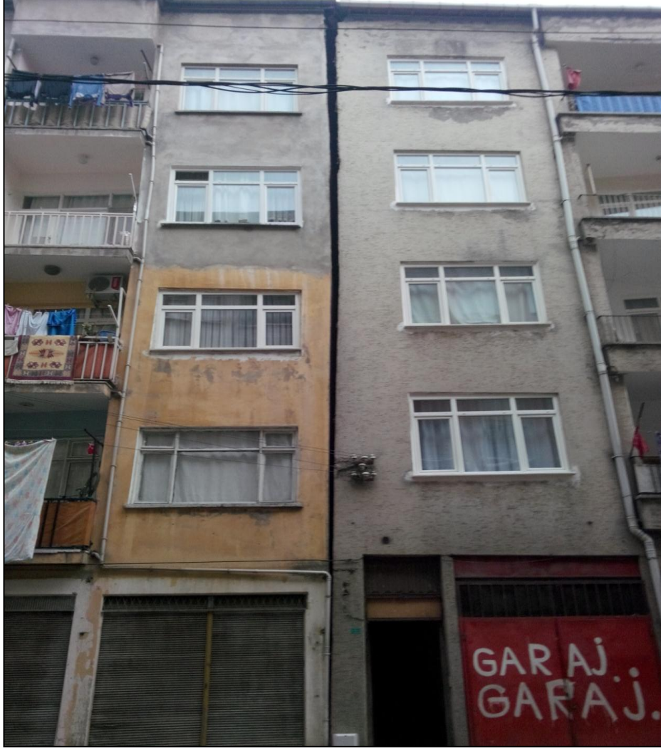
Fotoğraf 7: Hacı Siyam Mahallesiindeki Zeminden Kaynaklı Temelde Bitişik Üstte Ayrı Binalardan Bir Görünüm.
