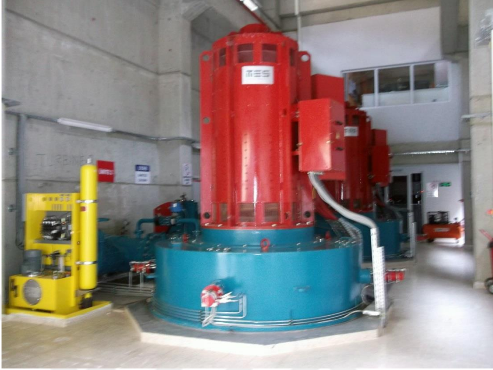
Fotoğraf 19. Tokmadin HES'in Dikey Tip Türbinleri
