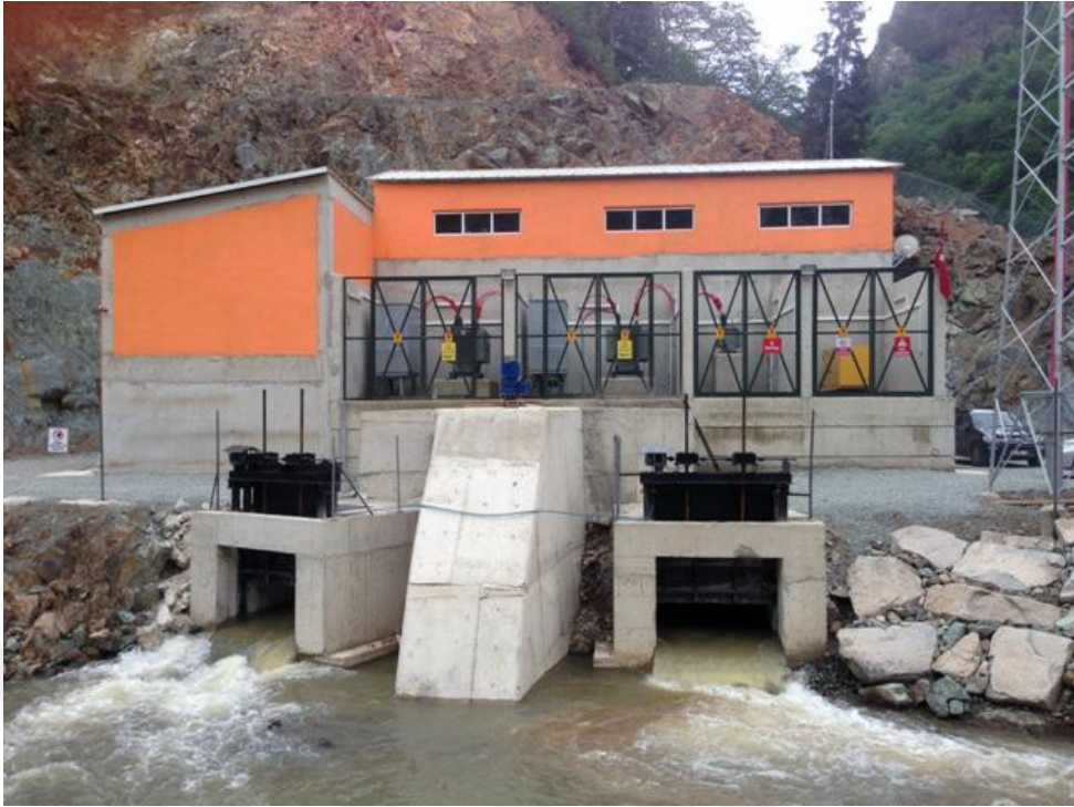
Fotoğraf 17. Tokmadin HES Ana Binası
