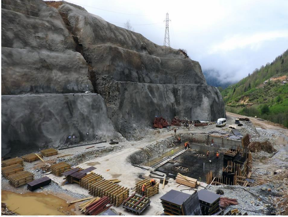
Fotoğraf 26. Çalıkobası HES İnşaat Alanından Bir Görünüm
