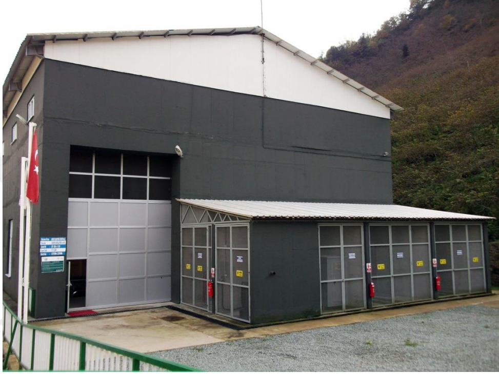
Fotoğraf 9. Zekere HES'in Ana Binası
