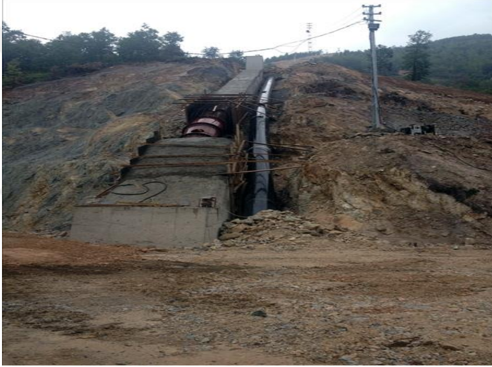
Fotoğraf 30. Çiğdem HES Cebri Borusu İçin Dökülen Betonlardan Bir Görünüm
