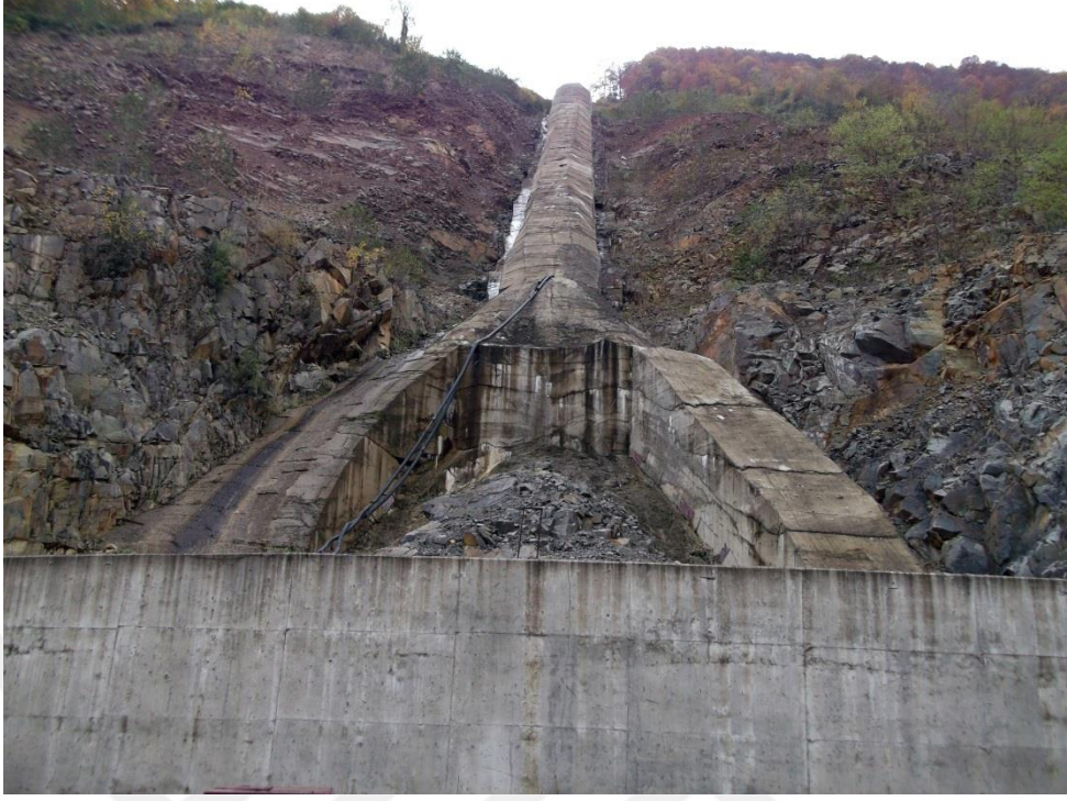
Fotoğraf 31. Ören HES Cebri Boruları ve Çevresindeki Betonlaşmadan Bir Görünüm
