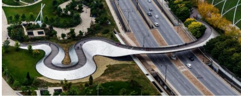
Resim 11: BP Yaya Köprüsü (BP Pedestrian Bridge)
