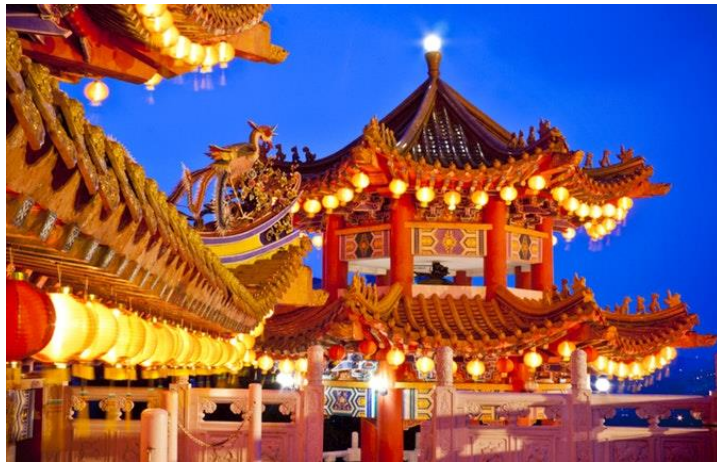
Resim 70: Thean Hou Tapınağı Çatı Detayı
