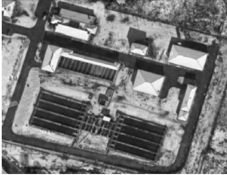
Şekil 2.2. Düzce Merkez İlçe İçme ve Kullanma Suyu Arıtma Tesisi Görünümü
