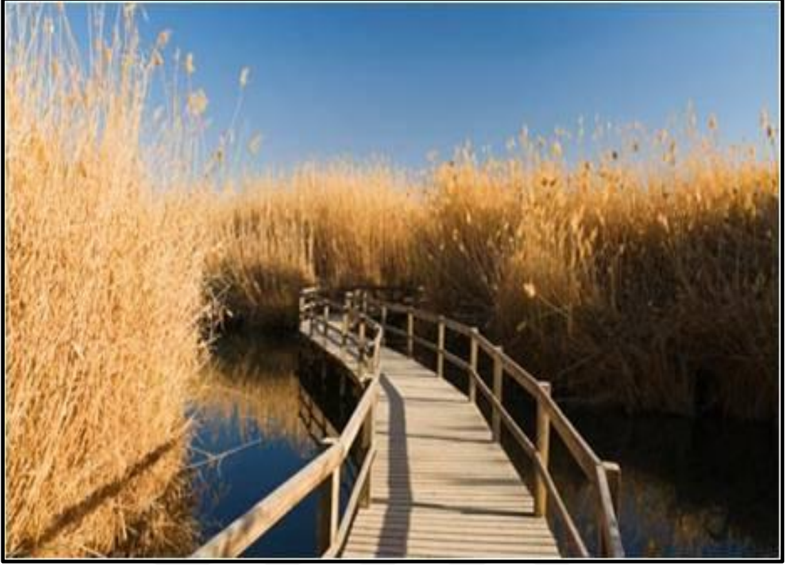
Resim 4.13a. Köprü örnek görünümü
