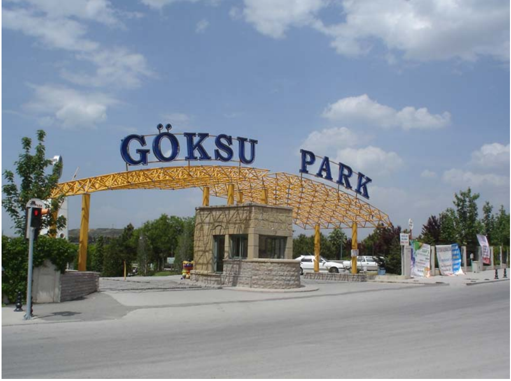
Şekil 15. Parktaki mevcut girişten bir görünüm (AŞIKKUTLU, 2008)
