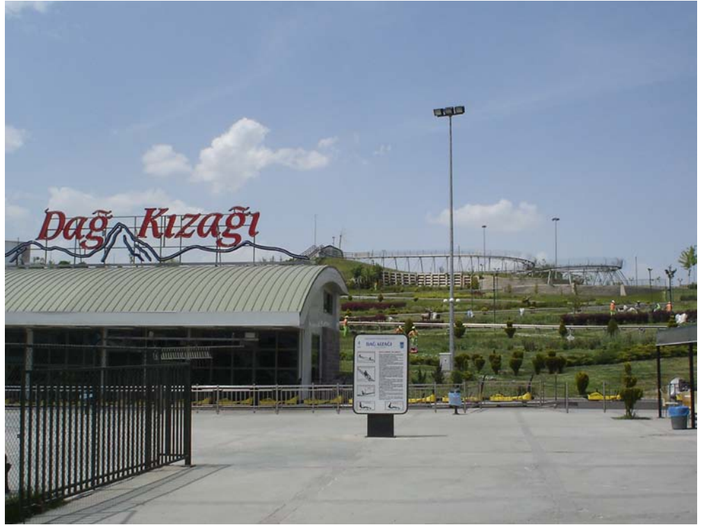
Şekil 4. Parktaki dağ kızıağı alanından bir görünüm (AŞIKKUTLU, 2008)
