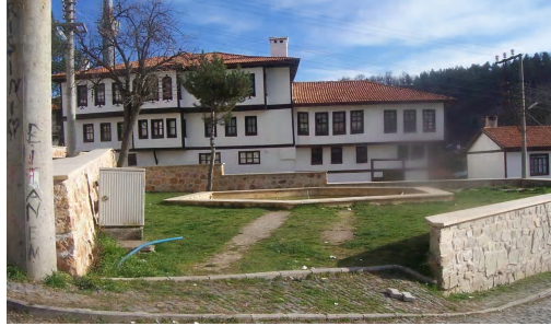
Şekil 3.12: Hızırfakı Mahallesi Alan Düzenlemesinden Bir Görünüm (Topaç, 2010)
