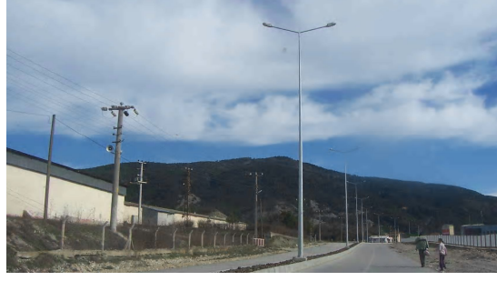
Şekil 3.25: Bölünmüş Yol Çalışmasından Bir Görünüm (Topaç, 2010)
