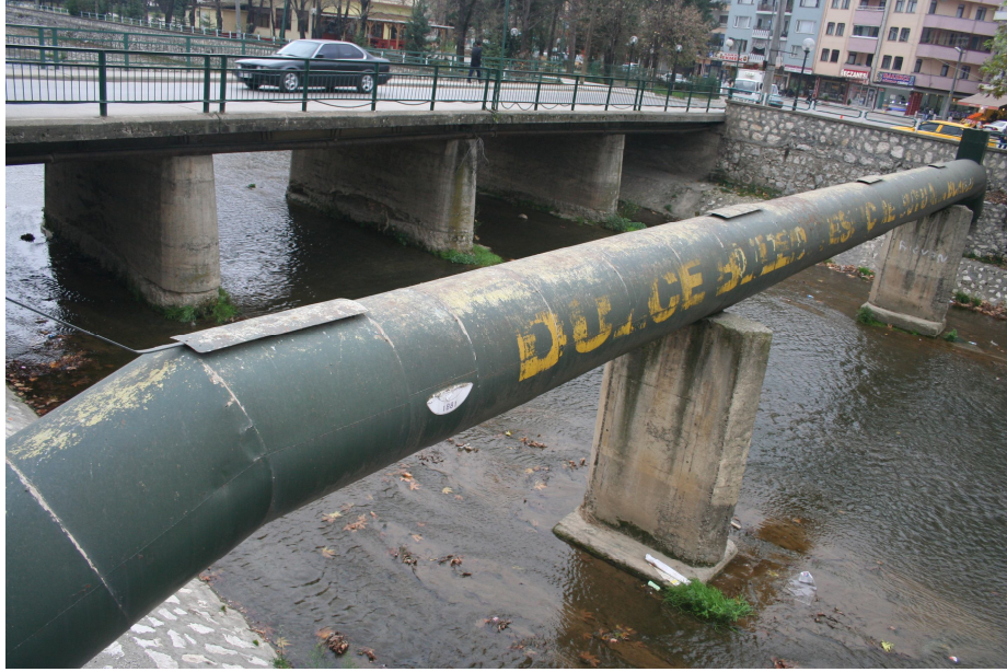
Şekil 4.16. Düzce Belediyesi İçme Suyu Ana Borusunun Geçtiği Bölümden Bir Görünüm (Özdede, 2010)
