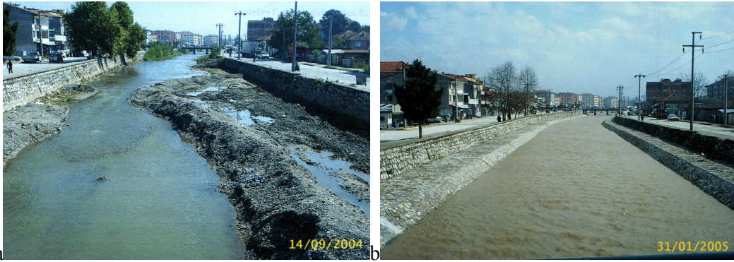
Şekil 4.7a,b. Asarsuyu Deresi Islah Çalışmasından Önceki Hali- Sonraki Hali (DSİ, 2007)
