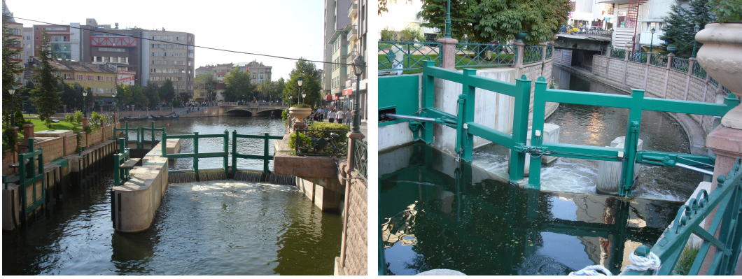
Şekil 5.1a,b. Eskişehir Su Seviye Kontrol Yapıları (Özdede, 2010)
