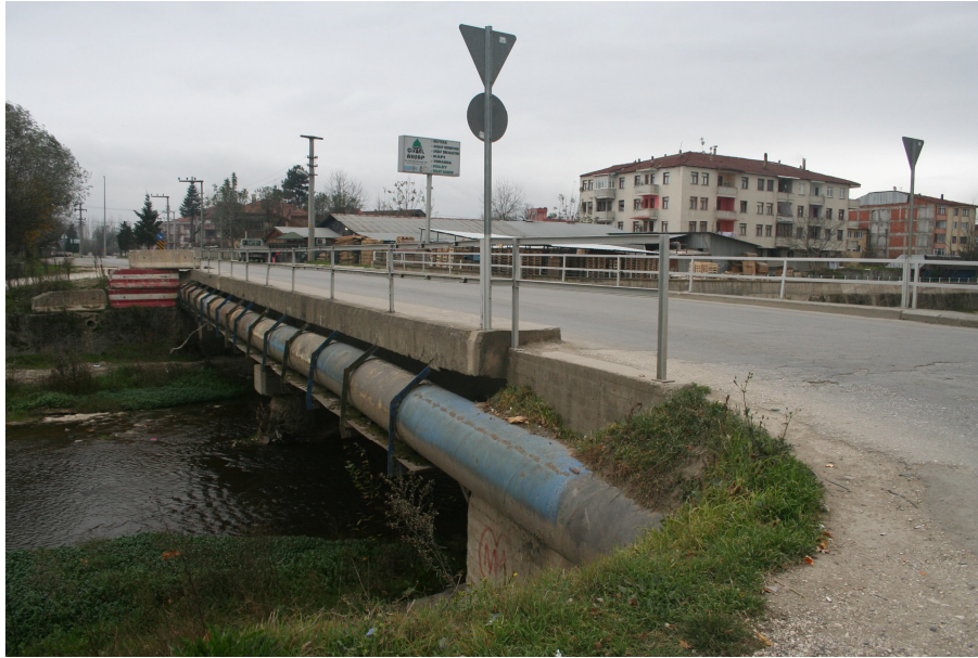
Şekil 4.17. Cedidiye Mahallesindeki Köprü (Özdede, 2010)
