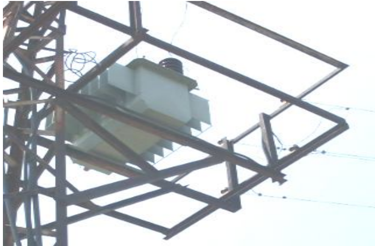
Şekil 2.15: Doğal soğutmalı yağlı transformatör
