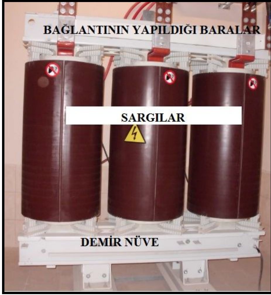
Şekil 2.22: Üç fazlı kuru tip transformatör
