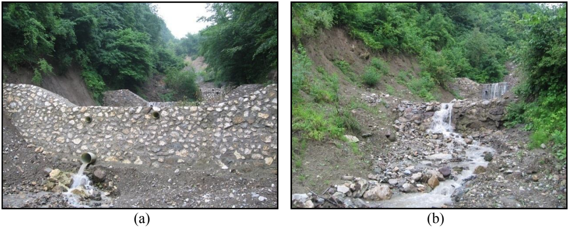
Şekil 5.1: Akbağlık deresinin ıslah sekileri (a), Akbağlık deresinde yamaç göçmeleri (b)
