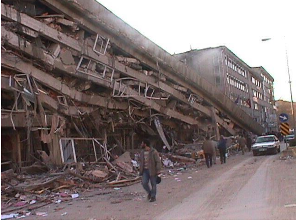
Şekil 2.12 : 12 Kasım 1999 depreminin Düzce'ye etkisi (Düzce Valiliği, 2002)
