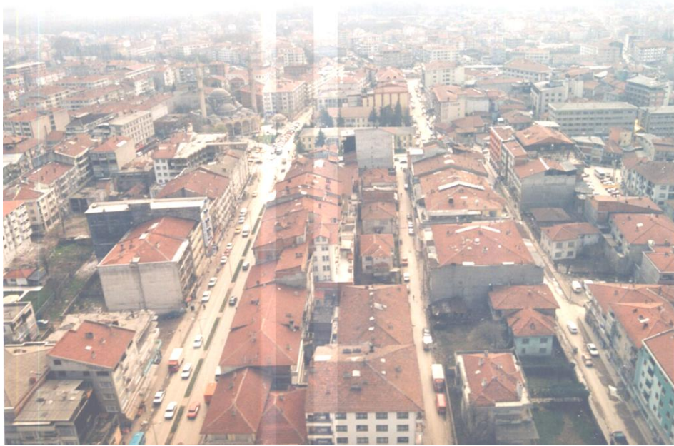
Şekil 2.11 : Deprem öncesi Düzce'den görünüm (Düzce Valiliği, 2002)
