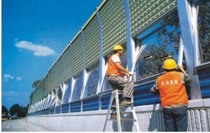
Şekil 1.16. Yapay bir gürültü perdesinin uygulama aşması (Anonim 2011f).
