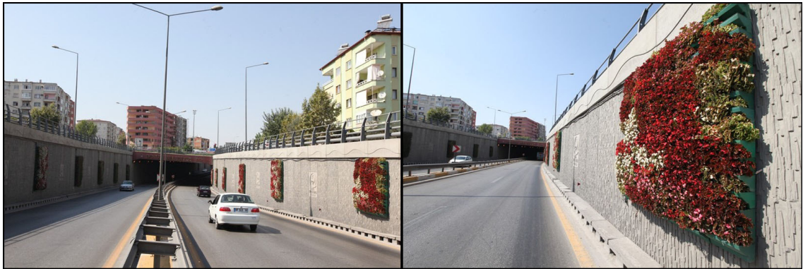
Şekil 1.42. Bahçe duvar örneği (Anonim, 2012m).
