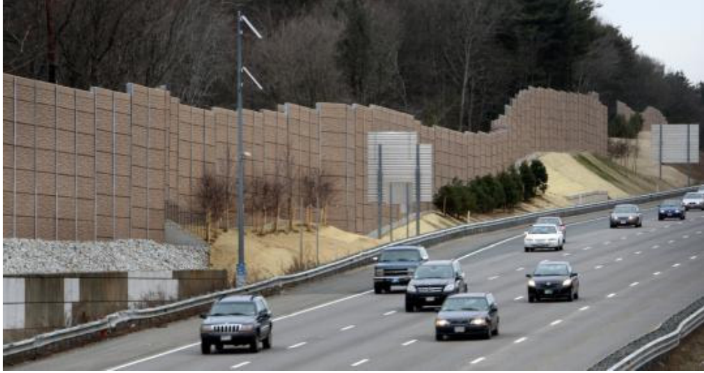
Şekil 1.19. Otoyol kenarında gürültüyü önlemek amaçlı bariyer uygulaması (Anonim 2011d).
