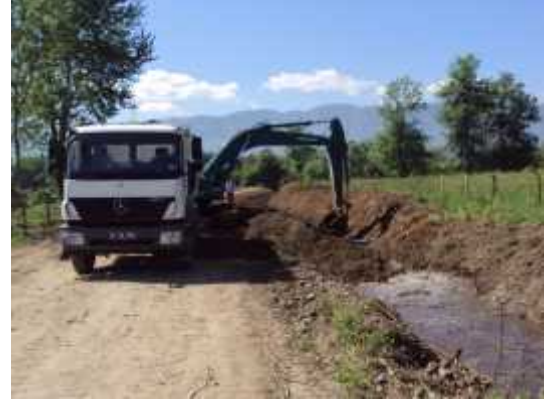
ekil 2.10. Drenaj kanalı yapımı
