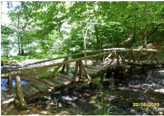
Şekil 2.18. Ahşap köprüden bir görünüm.
