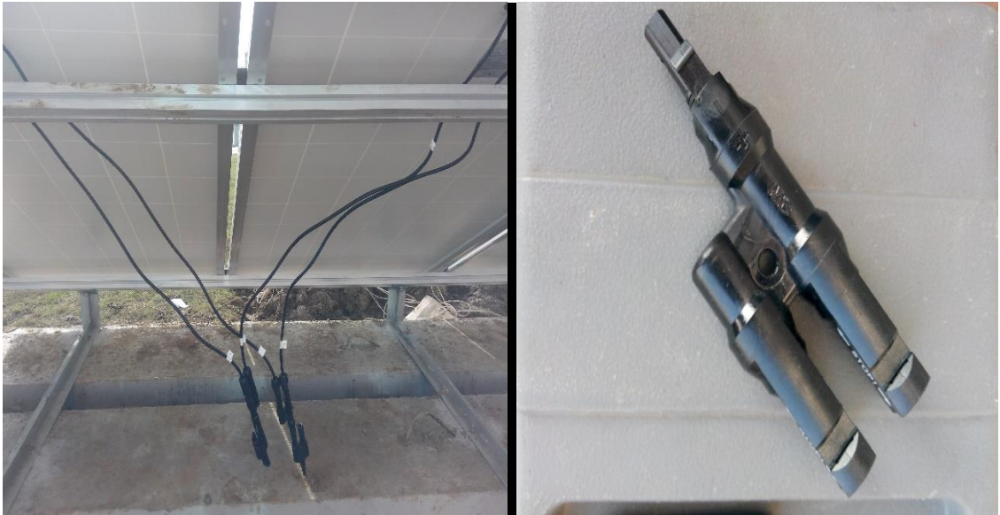
Şekil 3.21. Panellerin bağlanması ve bağlantı soketi
