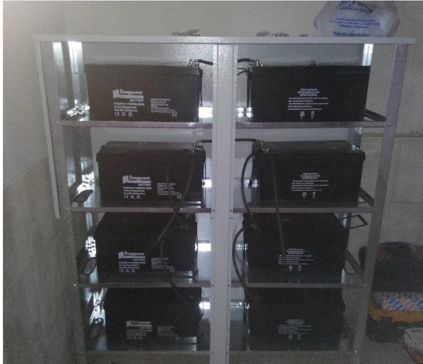
Şekil 3.22. Akülerin bağlanması
