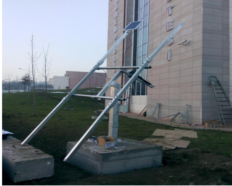
Şekil 3.16. Güneş takip eden sisteme profillerin montajı
