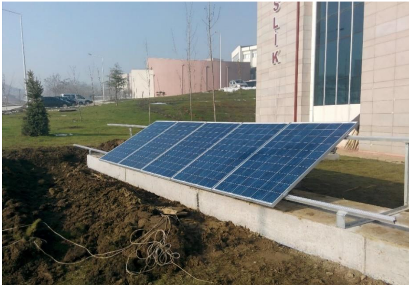
Şekil 3.19. Panellerin profillerin üstüne yerleştirilmesi
