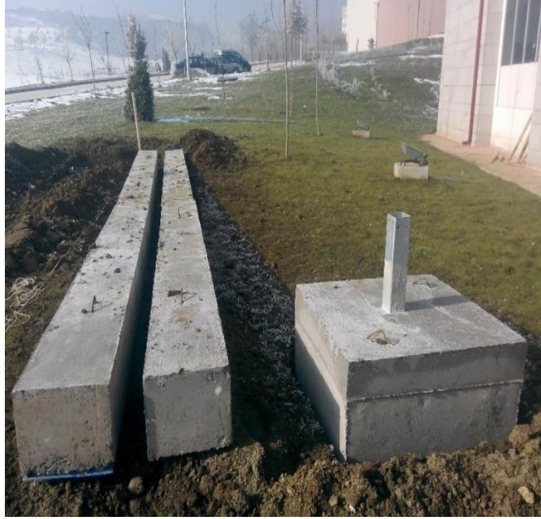
Şekil 3.14. Güneş panellerini sabitlemek için zeminin hazırlanması
