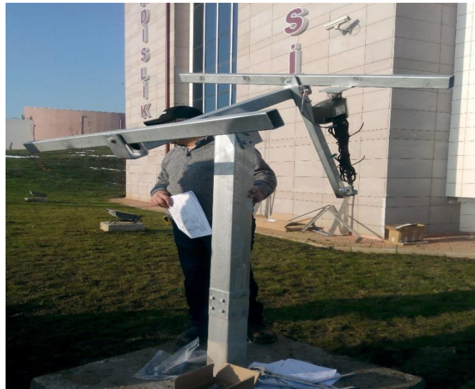
Şekil 3.15. Güneş takip eden sistemin montajı
