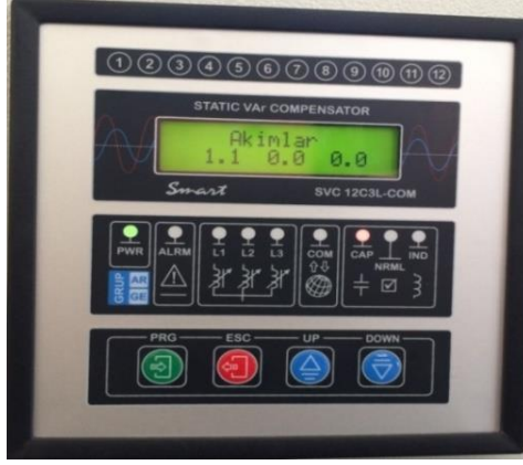
Şekil 3.6. L1 fazının yüklendiği andaki akım değeri.
