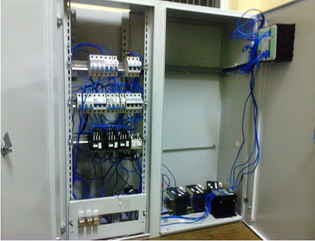
Şekil 2.2. SVC uygulamanın pano yerleşimi.
