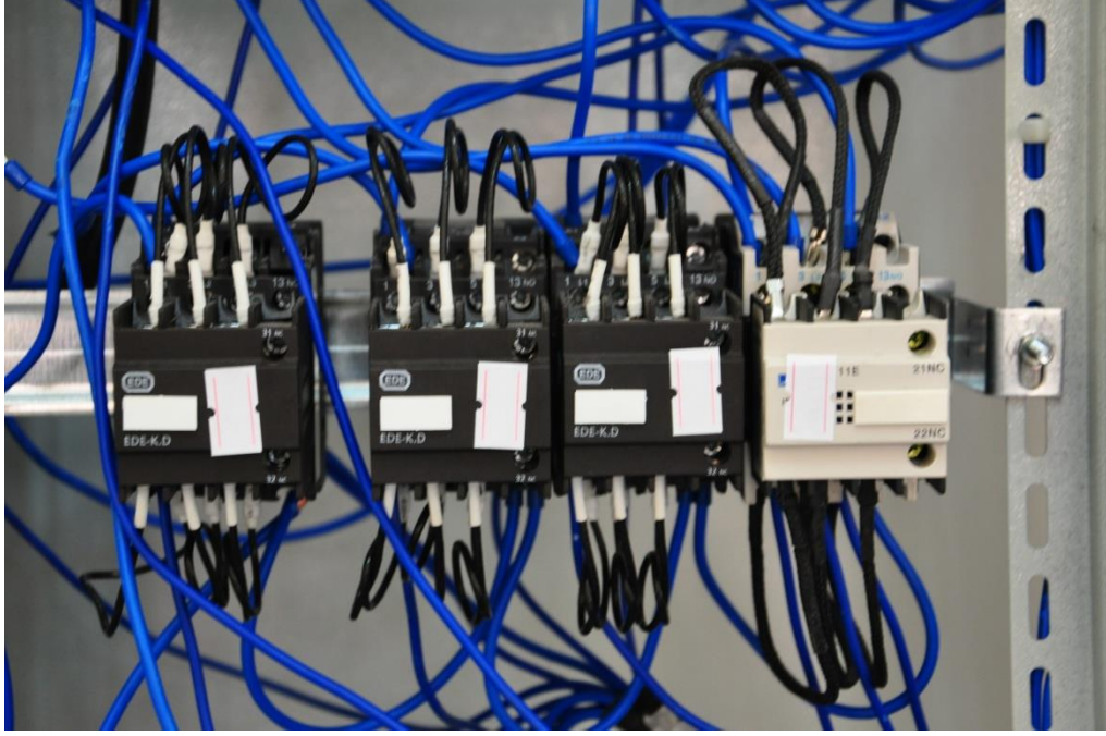
Şekil 2.9. Kompanzasyon kontaktörleri.
