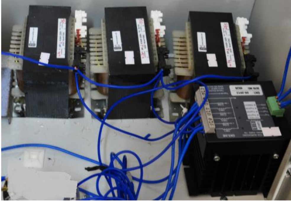
Şekil 2.24. Şönt reaktörler ve sürücü.
