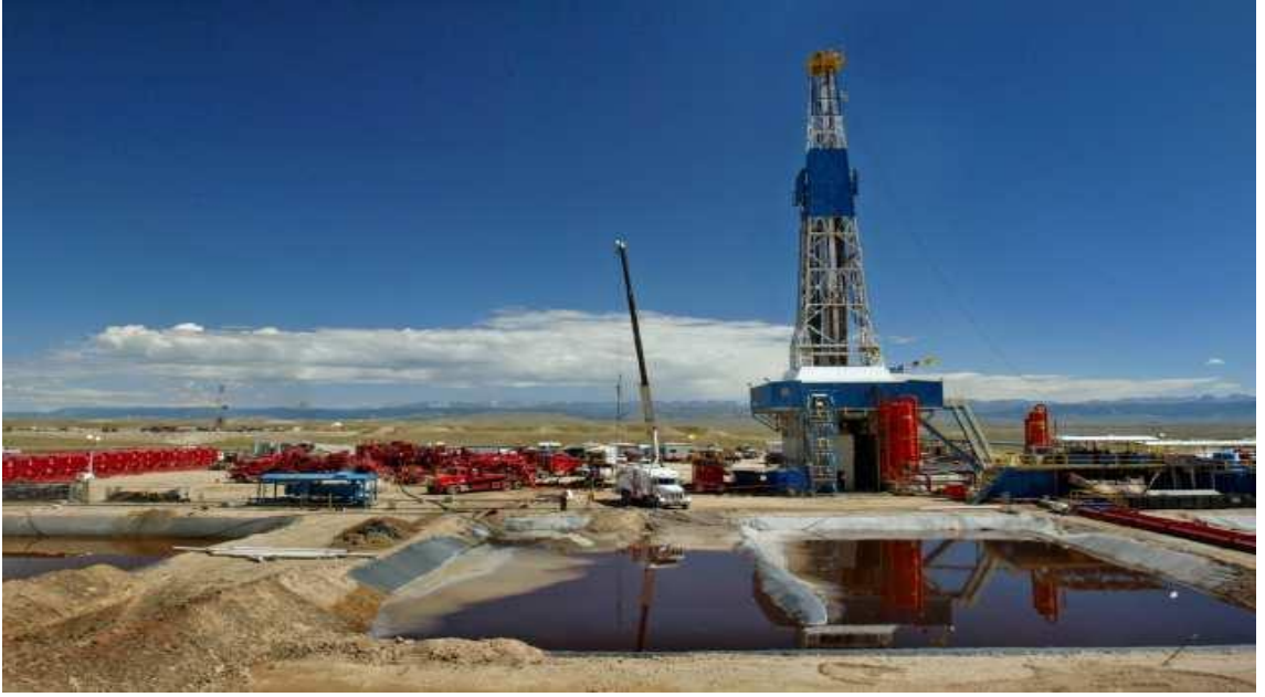
Şekil 2.16. Formasyon suyunu ve geri dönen suları toplama havuzları-2 [28]
