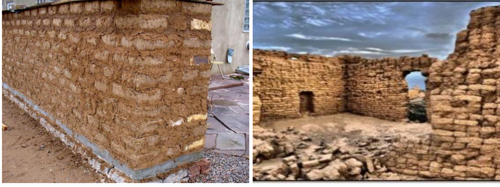
Şekil 1.3. Kerpiç tuğlalar ve derz aralarındaki kil harçları ve kerpiçten üretilen bir değirmenin kalıntıları (URL - 4; URL - 5)
