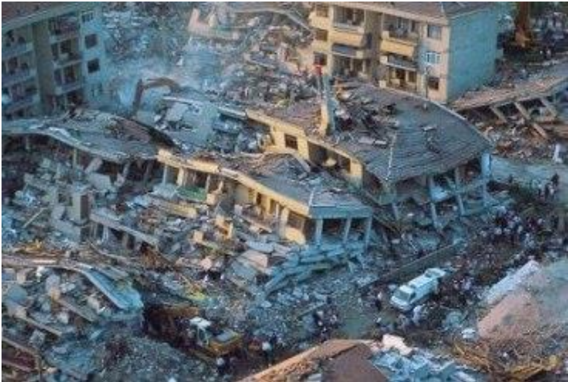
Şekil 1.3. Marmara depremi sonrasında yıkılan binalardan bir kesit (URL-1).
