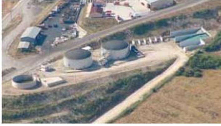
Şekil 3.2. Pilot biyogaz tesisi [25]
